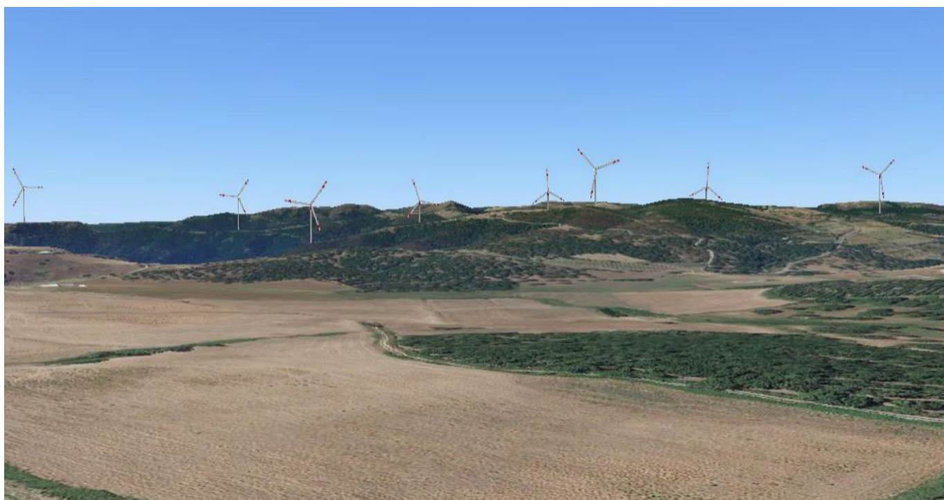
Vista da Siurgus – Immagine estratta da Sintesi non tecnica
