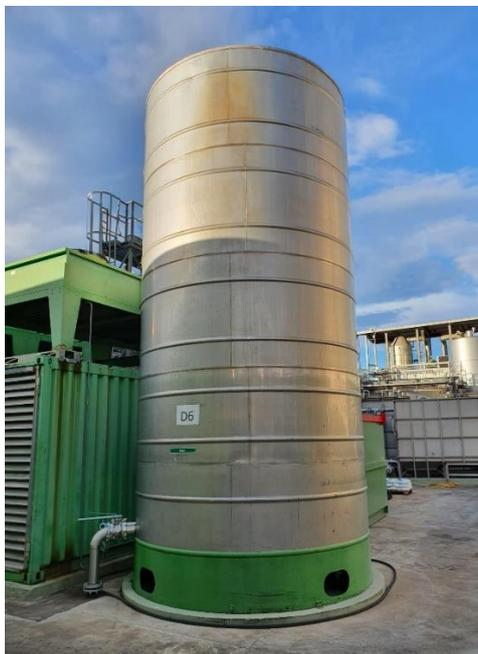
*Figura 29: tipo serbatoio in acciaio inox con serpentino di riscaldamento*
