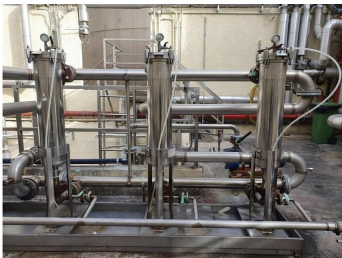
*Figura 30: modello tipo filtro a cestello con sacco filtrante interno*
