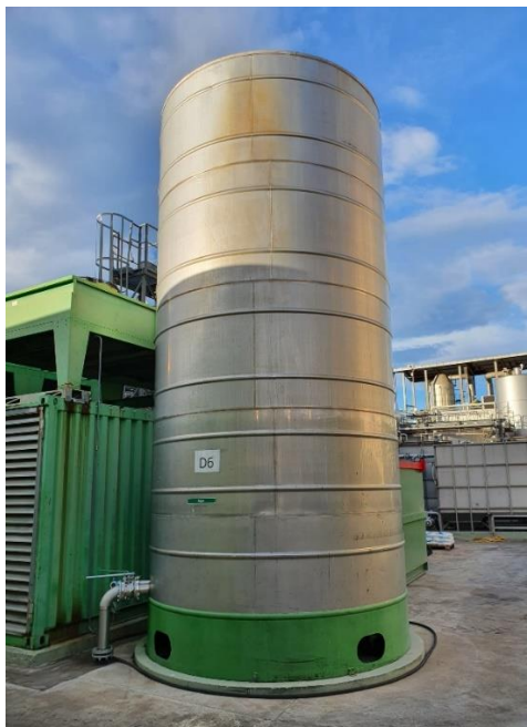
Figura 81: tipo serbatoio in acciaio inox con serpentino di riscaldamento
