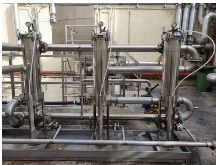
Figura 82: modello tipo filtro a cestello con sacco filtrante interno
