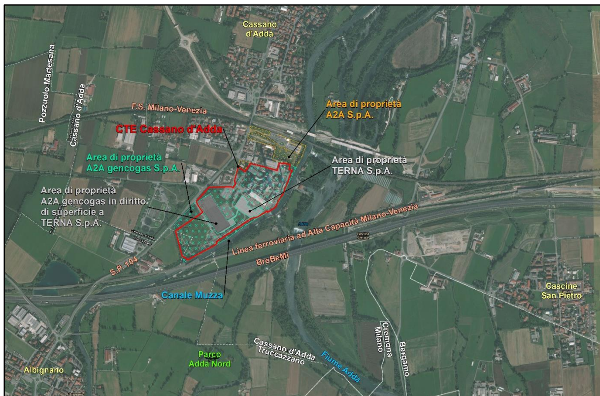
Figura 3.1a Localizzazione della Centrale Termoelettrica A2A gencogas di Cassano d'Adda
