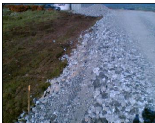
Figura 38 - Superficie stradale in misto stabilizzato e drenaggio
