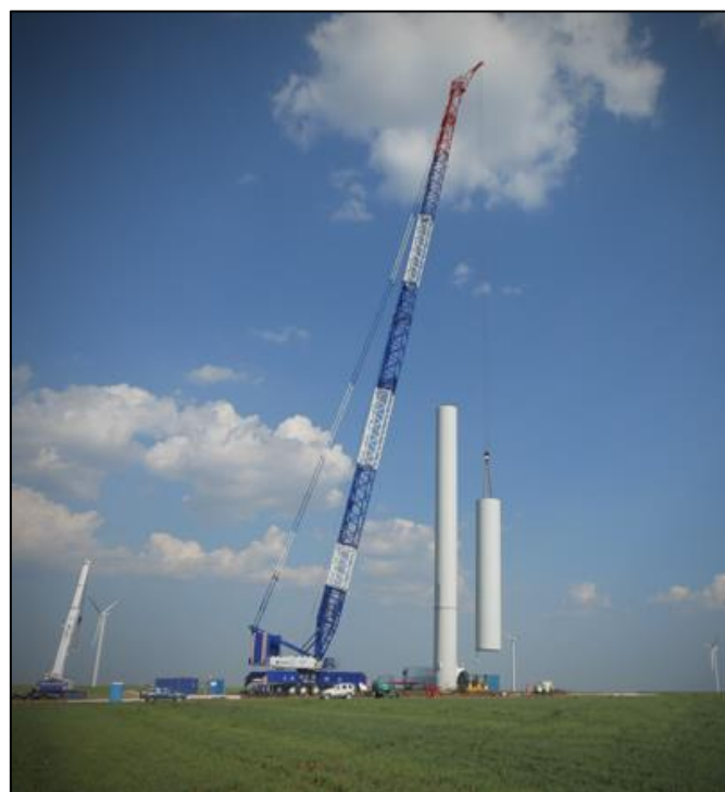
Figura 45 - Sollevamento, posizionamento e fissaggio dei tronconi intermedi
