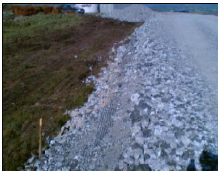
Figura 41 - Superficie stradale in misto stabilizzato e drenaggio
