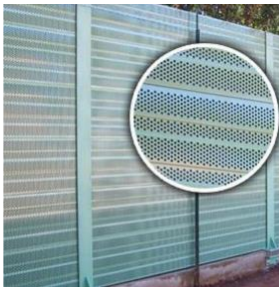
FIGURA 10: BARRIERA FONOMETRICA PER L'ABBATTIMENTO DEL RUMORE
