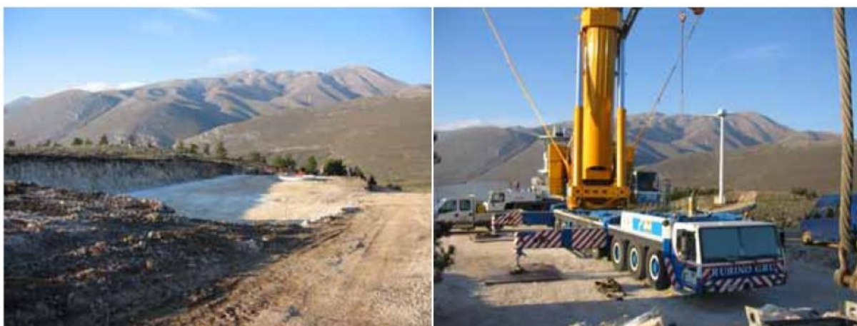
FIGURA 14: PIAZZOLE E GRU PER IL MONTAGGIO PALE
