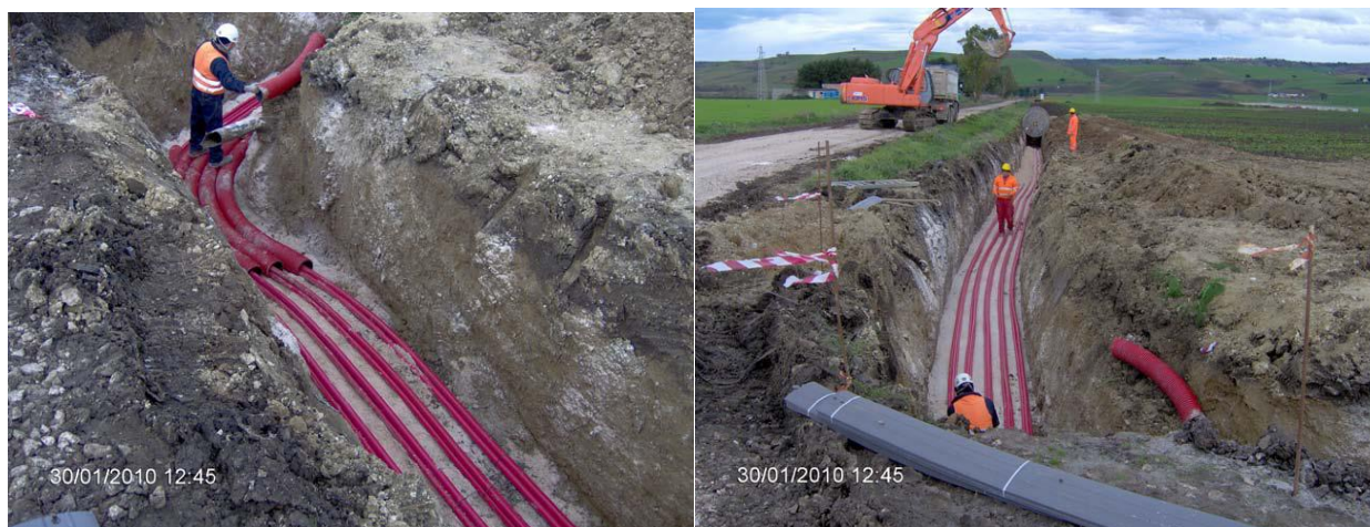
FIGURA 12: POSA IN OPERA DEI CAVI
