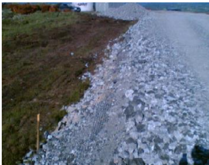
FIGURA 8: SUPERFICIE STRADALE IN MISTO STABILIZZATO E DRENAGGIO
