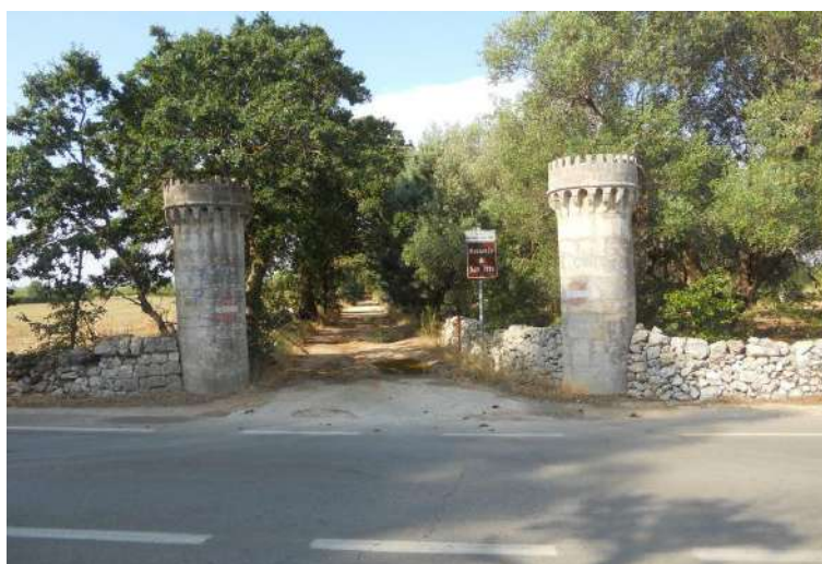
Figura 48: ingresso Masseria S. Vito
