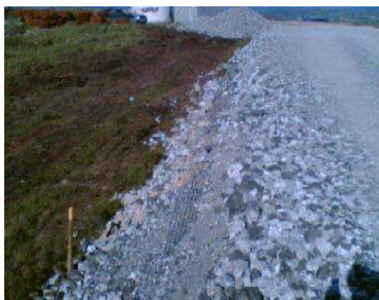
Figura 13: Superficie stradale in misto stabilizzato e drenaggio
