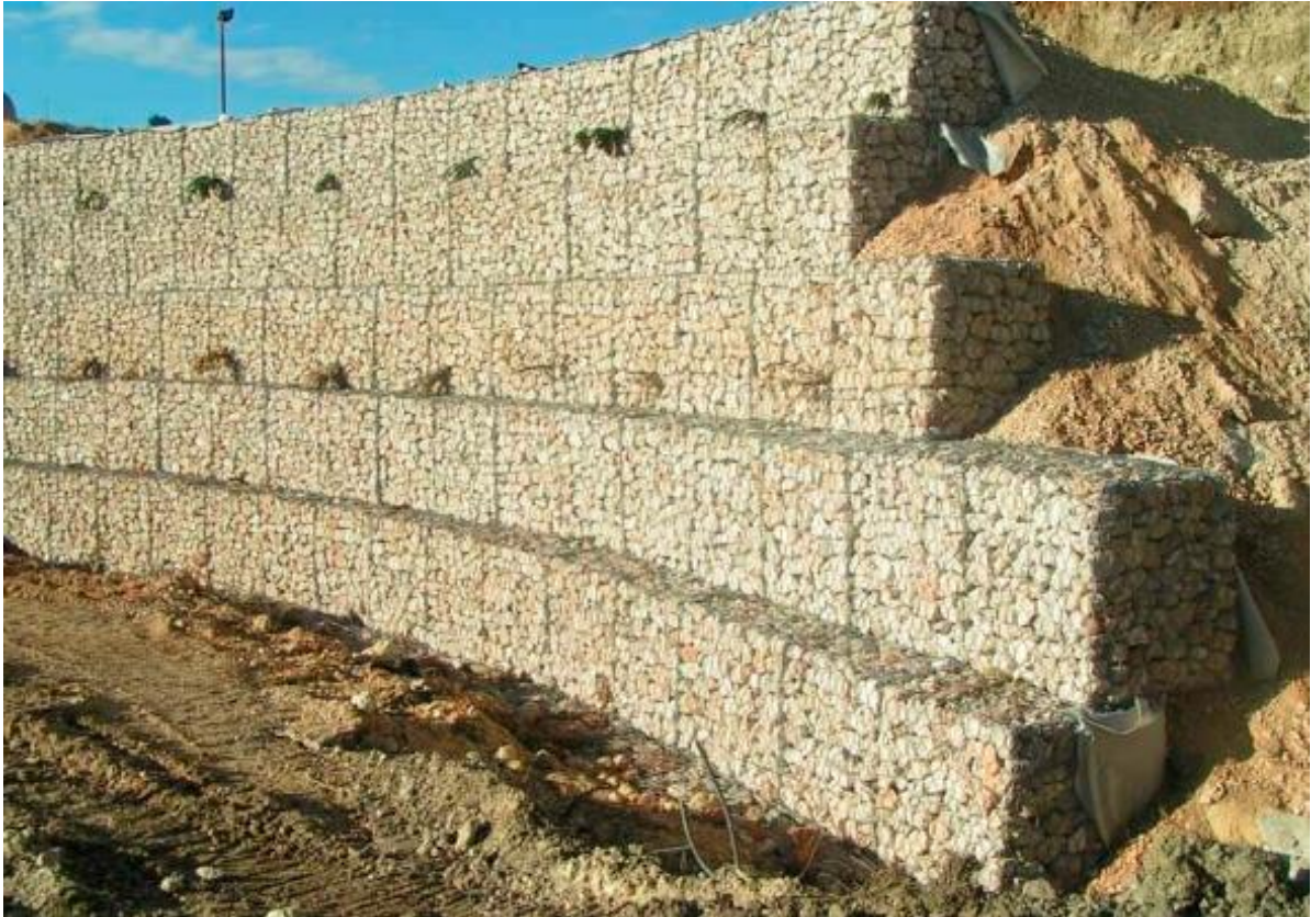
Figura 9 - Esempio di gabbionate rinverdite
