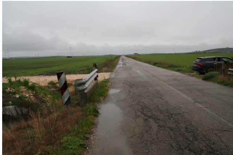
foto 16 – 17 - 18 Percorso del cavidotto esterno al parco su strada asfaltata (Archivio Goegin Energy srl)
