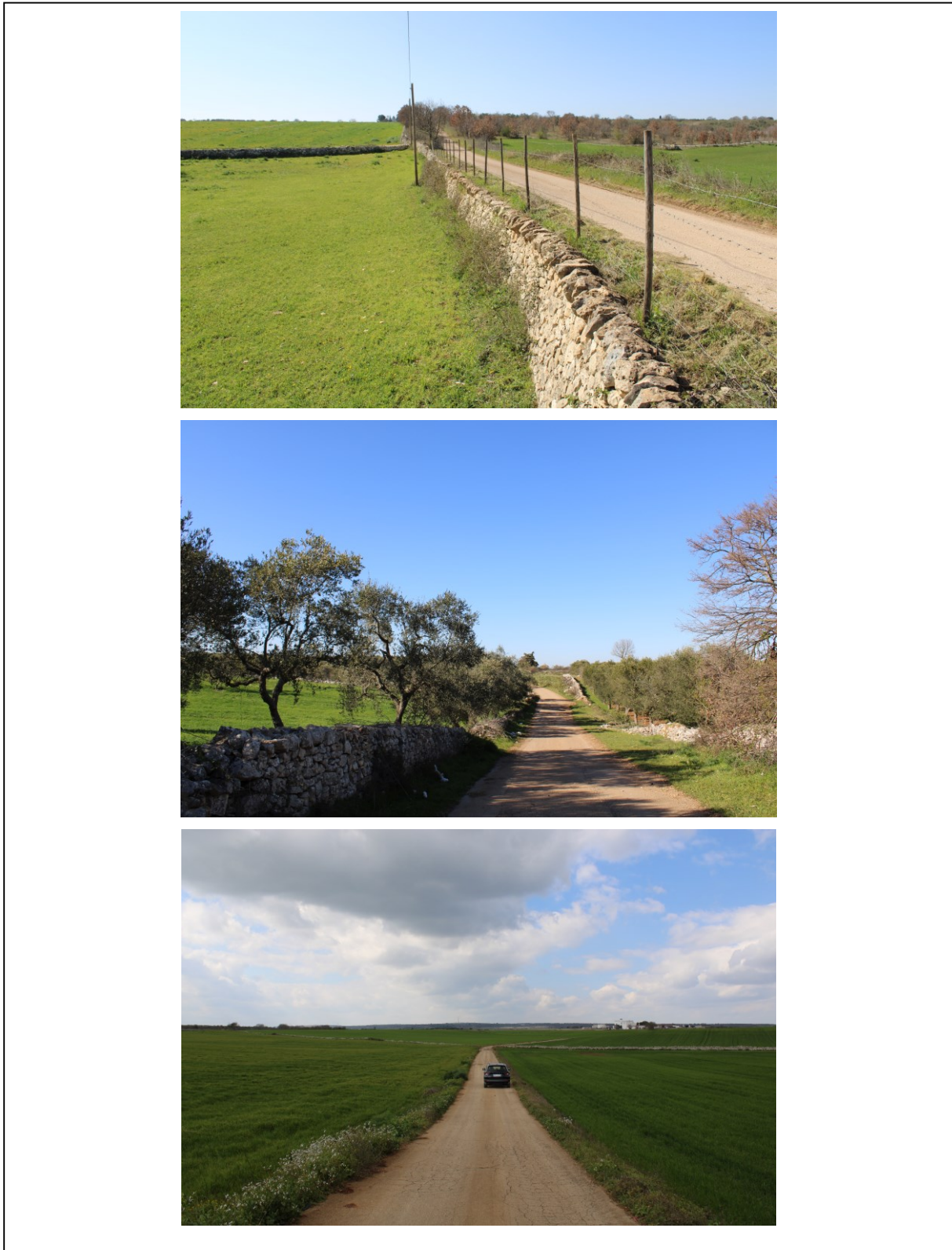
foto 13 – 14 - 15 | Percorso del cavidotto esterno al parco su strada asfaltata (Archivio Goegin Energy srl)
