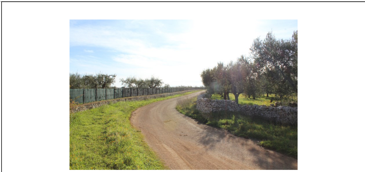
foto 25 | Viabilità interna al parco eolico in prossimità di H9 (Archivio Goegin Energy srl)
