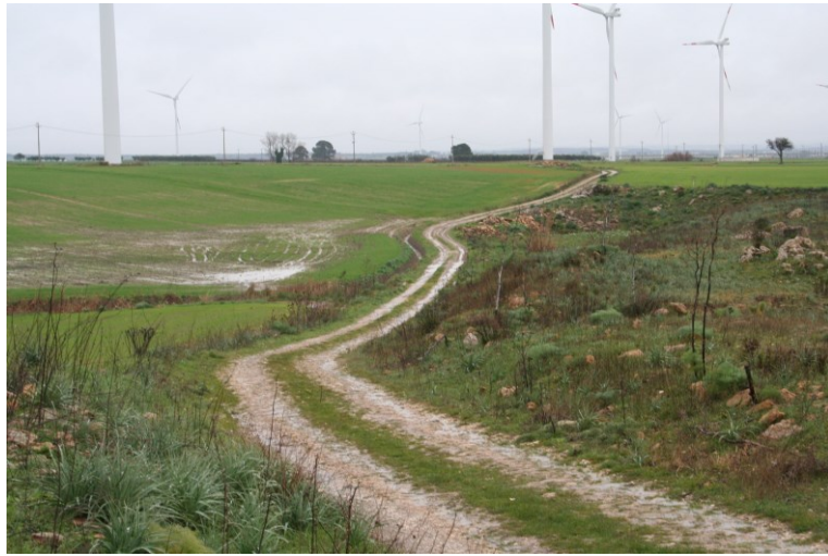
foto 19 | Viabilità di accesso alla MT di Castellaneta (Archivio Goegin Energy srl)
