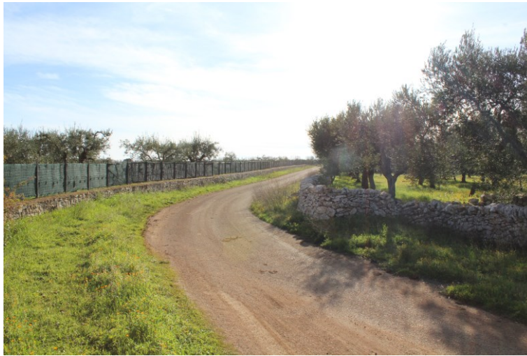
foto 25 | Viabilità interna al parco eolico in prossimità di H9 (Archivio Goegin Energy srl)
