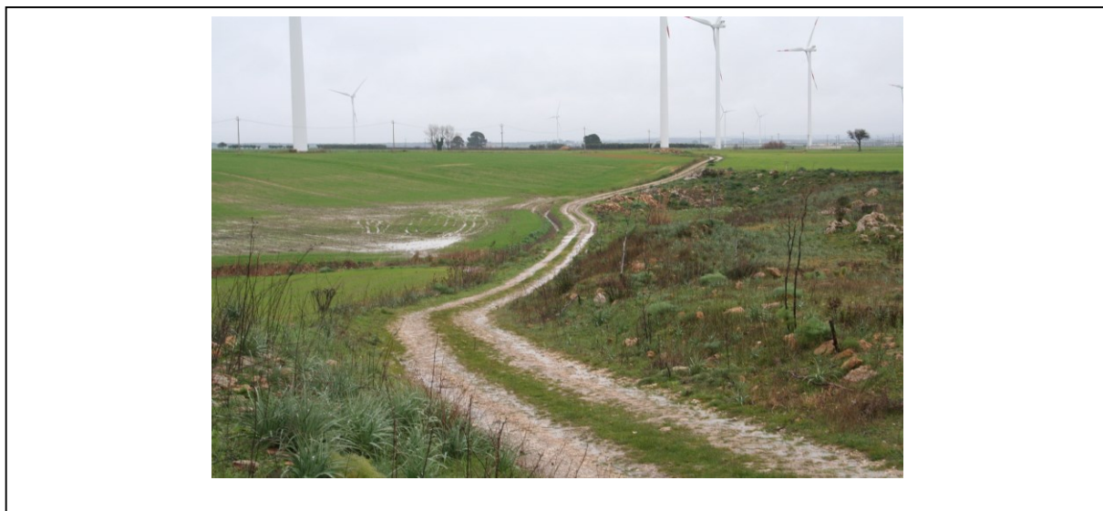
foto 19 | Viabilità di accesso alla MT di Castellaneta (Archivio Goegin Energy srl)
