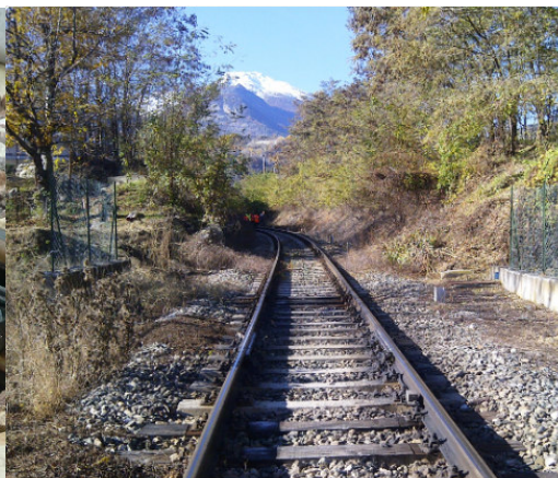
Impianto lubrificazione P.A.L. Italia (Foto: P.A.L. Italia; 2012)
