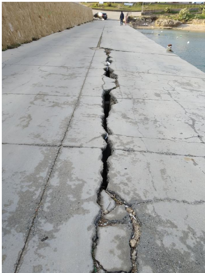
Vista banchina lato interno del molo sopraflutto ante operam
