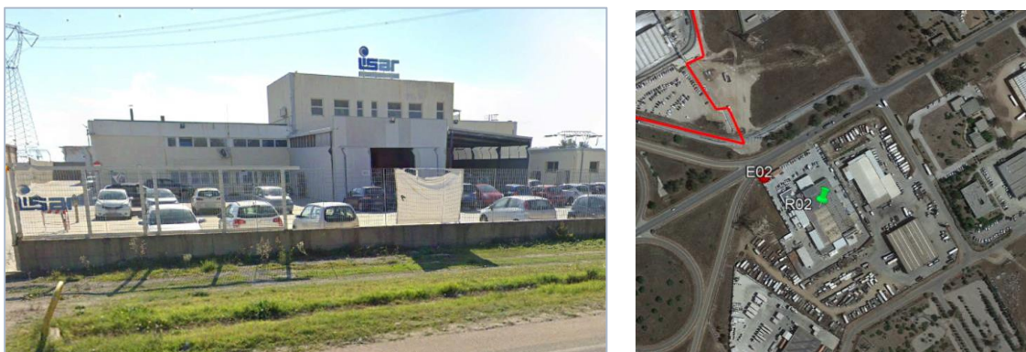
Figura 3:5 Documentazione fotografica e posizionamento fonometro - R02 – E02
