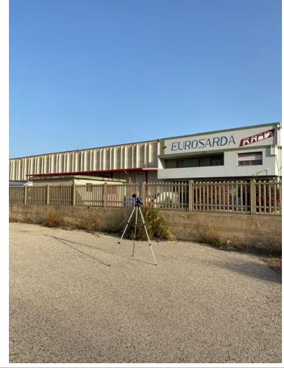
POSTAZIONE DI MISURA
