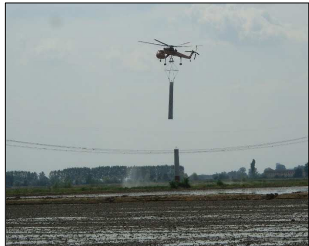
Figura 6: Elicottero durante le operazioni di posa della parte aerea del sostegno
