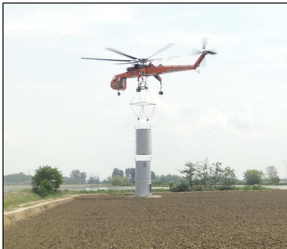
Figura 6: Elicottero durante le operazioni di posa della parte aerea del sostegno
