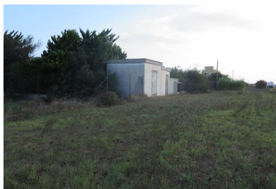
Panoramica UR 4. Veduta da sud ovest.
