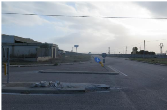
Panoramica UR 2. Veduta da sud ovest.
