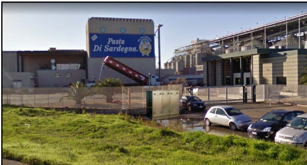
Figura 22– GRMI Pastificio Cellino - Via Maldiventre- Foto post-operam
