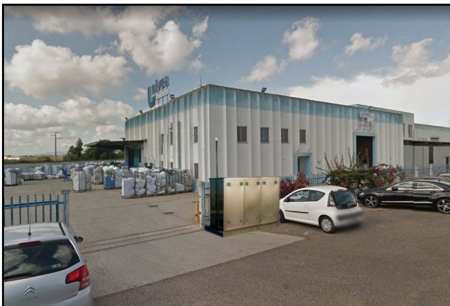
Figura 16 – GRMI Nivea-Mareblu - Via Ginevra- Foto post-operam
