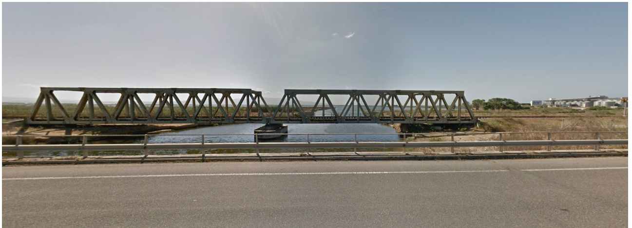
Figura 4-55 Ponte ferroviario di attraversamento del canale Pesaria.
