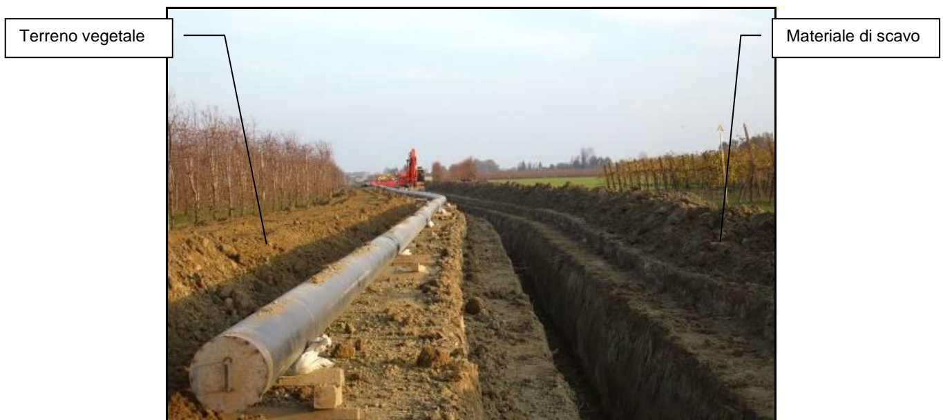
Fig. 4.4/C: Scavo della trincea
