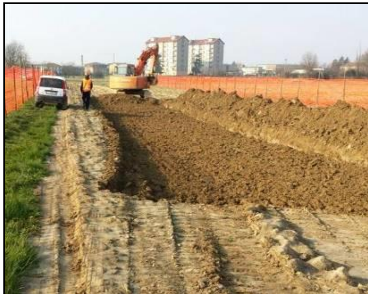
Fig. 4.4/B: Apertura della pista di lavoro
