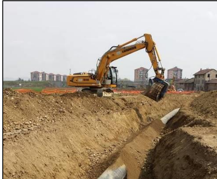
Fig. 4.4/D: Rinterro della condotta
