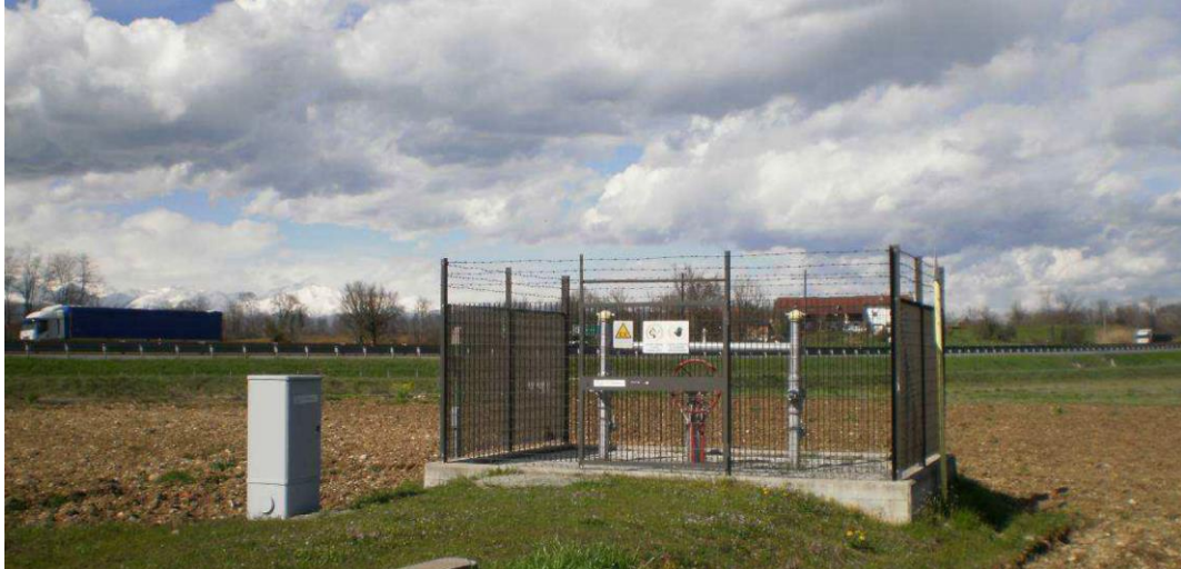
Fig. 4.4/H – Punto di Intercettazione di Linea (PIL)
