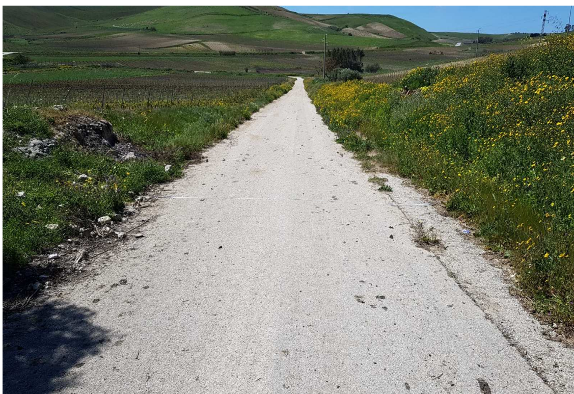
Figura 34 - Viabilità interno parco – Larghezza 5 m
