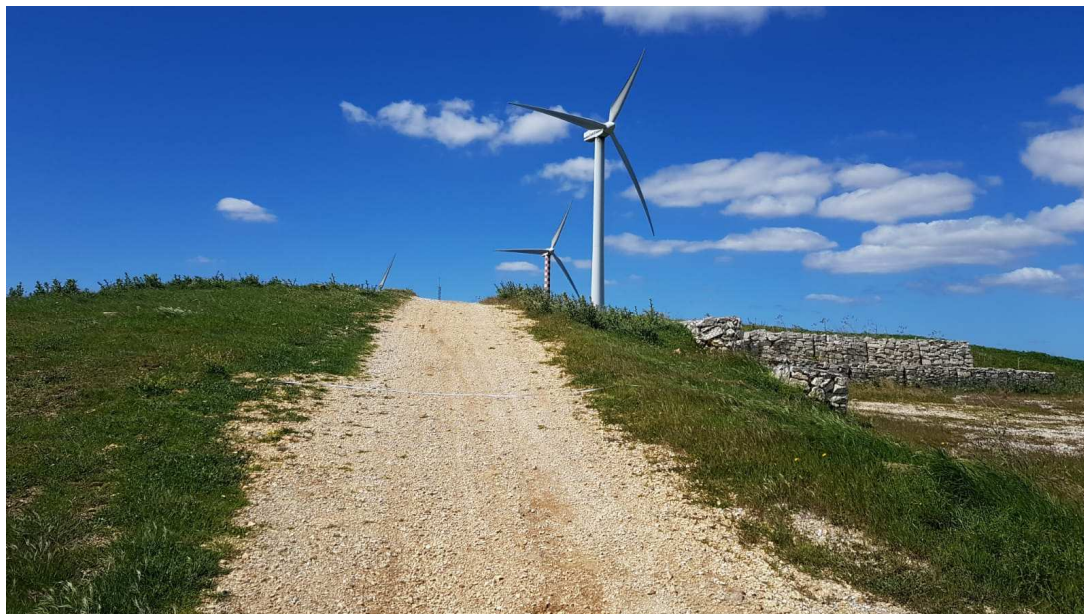
Figura 27 - Viabilità interno parco – Larghezza 4 m
