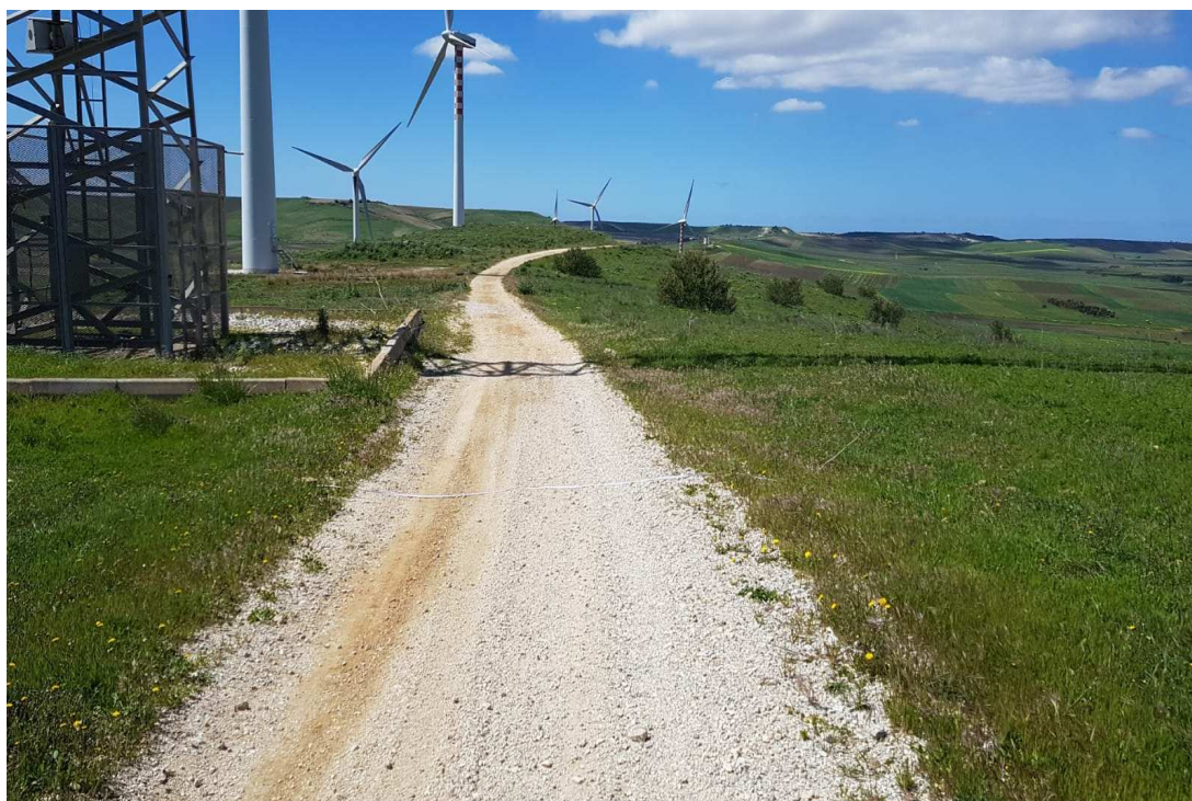
Figura 29 - Viabilità interno parco – Larghezza 3,7 m
