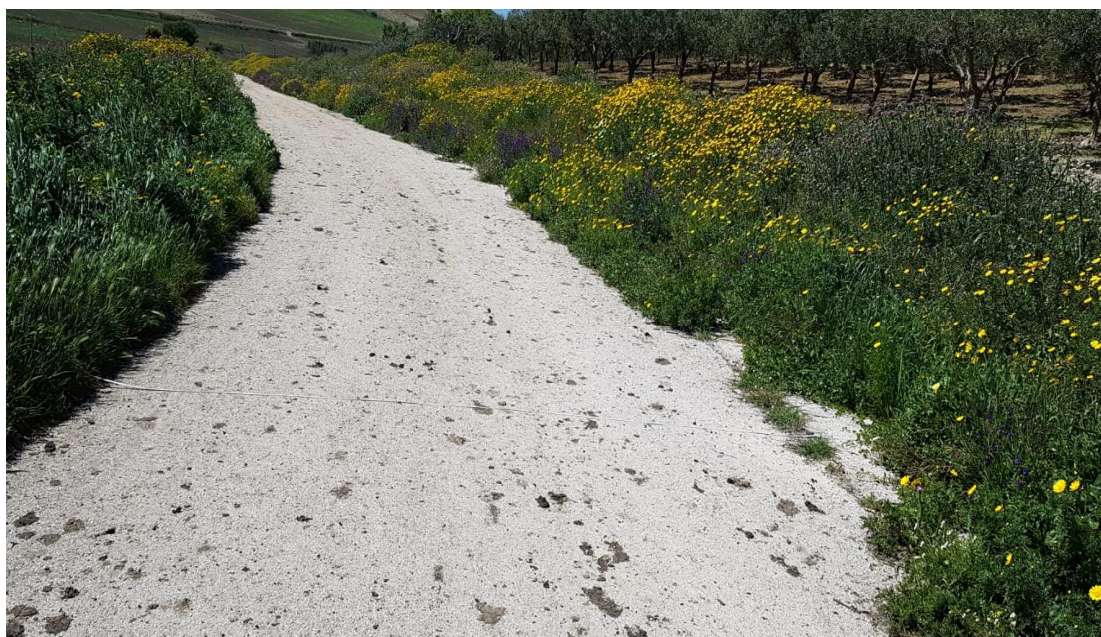
Figura 33 - Viabilità interno parco – Larghezza 4,8 m
