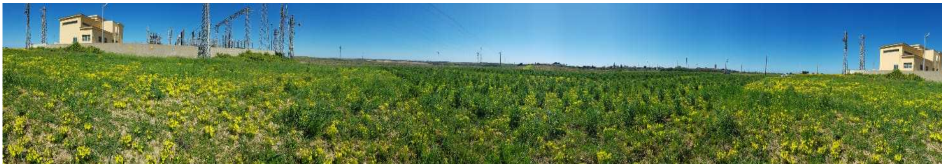
Figura 24 - Panoramica SSE Utente
