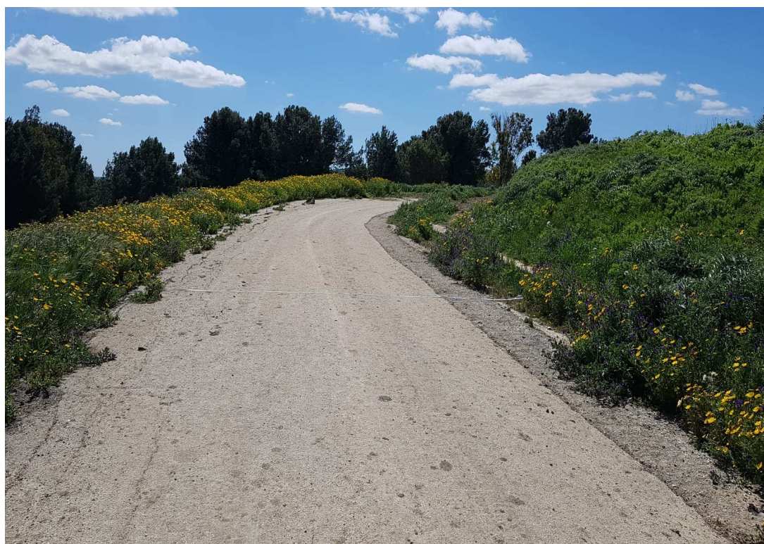
Figura 32 - Viabilità interno parco – Larghezza 5,9 m
