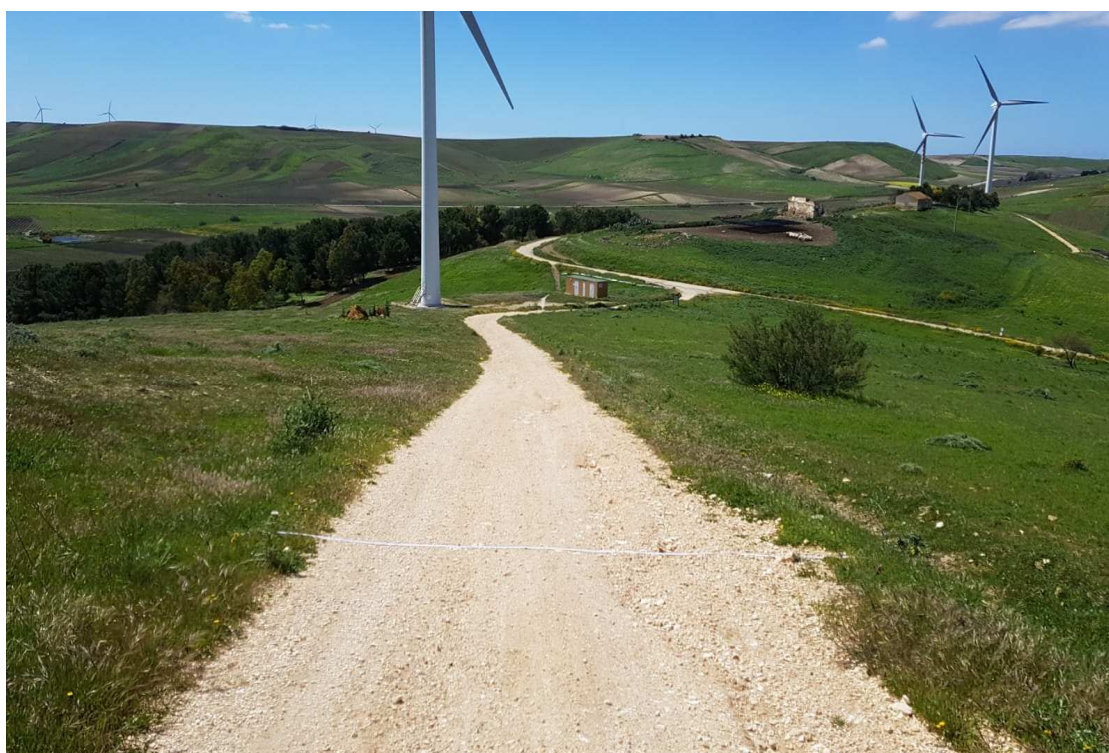
Figura 30 - Viabilità interno parco – Larghezza 5,2 m
