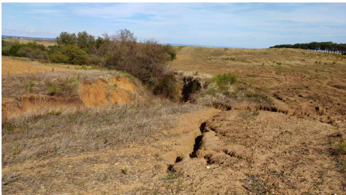
Foto 4: Area ricognita, vista da W verso E. Processo erosivo.
