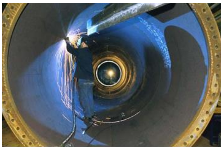
Figura 10: interno di una torre
