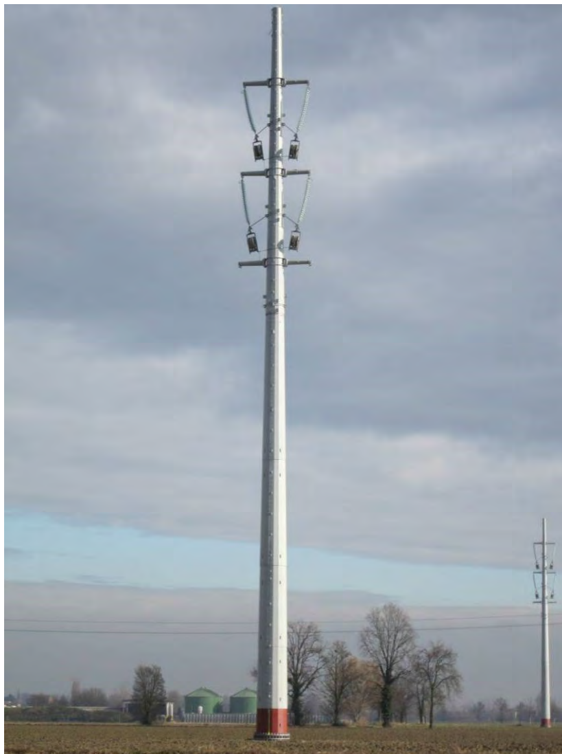
Sostegno monostelo montato. Si notino le carrucole collegate alle catene degli isolatori, fase che precede la "tesatura" dei conduttori (immagine d'archivio)
