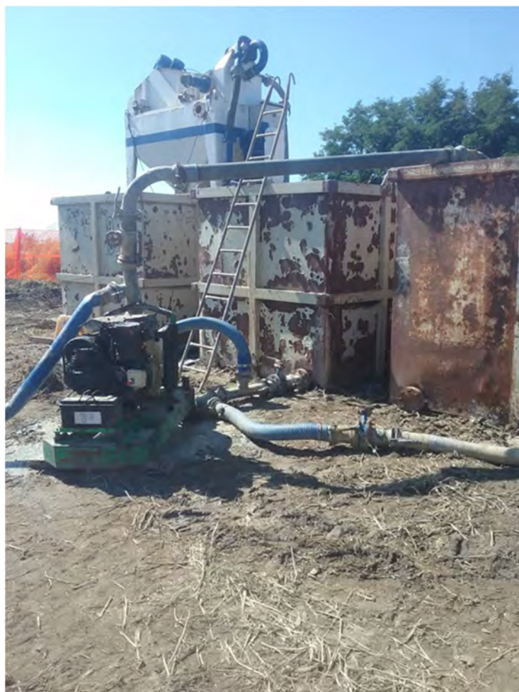
Allestimento di un impianto a circuito chiuso per la realizzazione di pali trivellati mediante l'utilizzo di fanghi bentonitici. In questa immagine si osservano la vasca prefabbricata per la decantazione del fango e la pompa di rilancio del fango verso il foro (immagine d'archivio)
