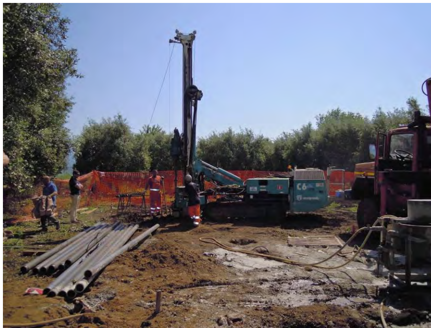
Cantiere per la realizzazione di micropali tipo tubfix; si può osservare sulla sinistra la zona di deposito dei tubolari metallici i quali costituiranno l'armatura dei micropali e sulla destra il miscelatore per la preparazione della boiaccia di cemento per l'iniezione a gravità dei micropali (immagine d'archivio)
