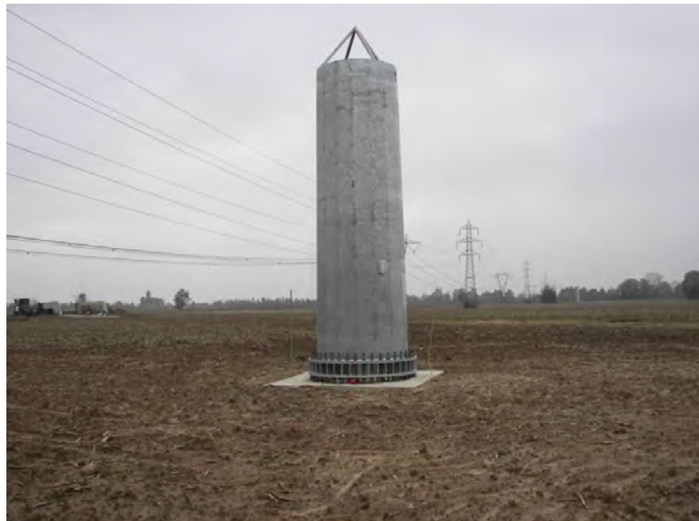
Realizzazione di fondazioni superficiali tipo plinto a monoblocco per un sostegno monostelo. Nell'immagine si può osservare una fondazione completata e la sistemazione del terreno nell'area circostante; come si vede nessuna parte della fondazione emerge dal piano campagna (immagine d'archivio)
