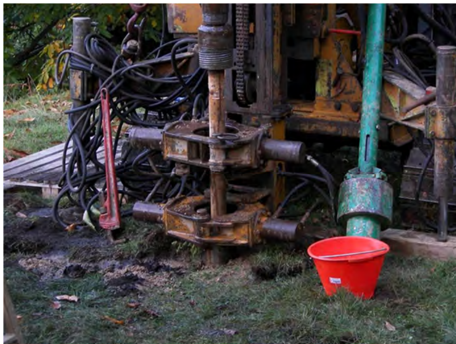
Macchina operatrice per la realizzazione di micropali tubfix; sistema di scavo a rotopercolazione (immagine d'archivio)
