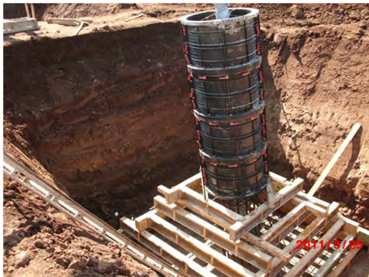
Realizzazione di fondazioni superficiali tipo CR per un sostegno a traliccio. Nell'immagine si può osservare la fase di cassetatura (immagine d'archivio)
