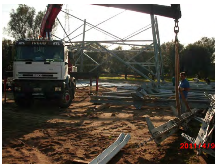
Fasi di montaggio sostegno a traliccio (immagine d'archivio)
