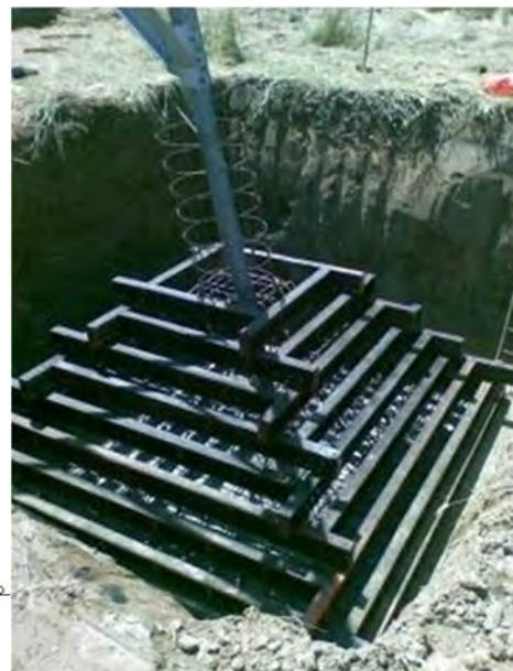
Esempio di realizzazione di una fondazione a plinto con riseghe - 1^ immagine: disegno di progetto 2^ immagine: fase di cassetatura della fondazione (immagine d'archivio)
