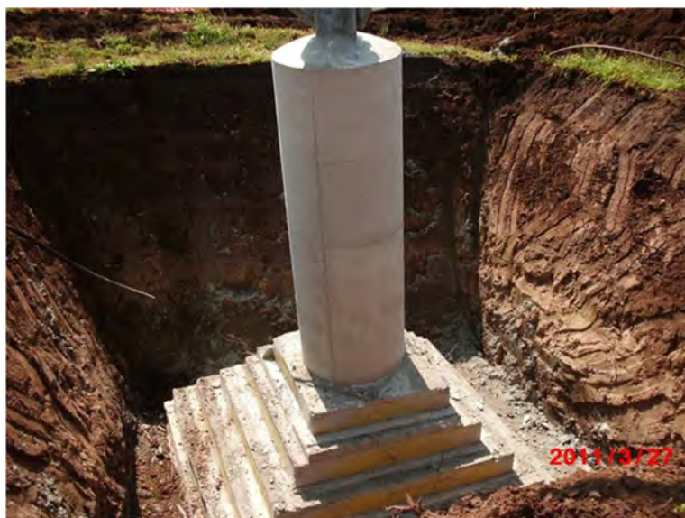
Realizzazione di fondazioni superficiali tipo CR per un sostegno a traliccio. Nell'immagine si può osservare una fondazione CR appena "scasserata". Si possono distinguere facilmente la parte inferiore a parallelepipedo tronco piramidali ed il colonnino di raccordo con la "base" del sostegno (immagine d'archivio)
