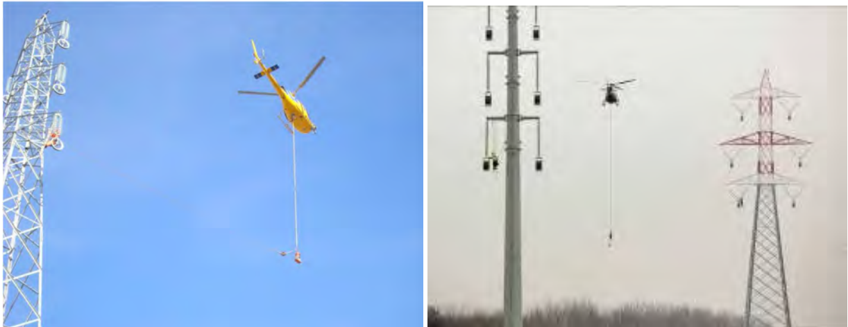
Utilizzo dell'elicottero per la stesura della fune pilota (immagine d'archivio)
