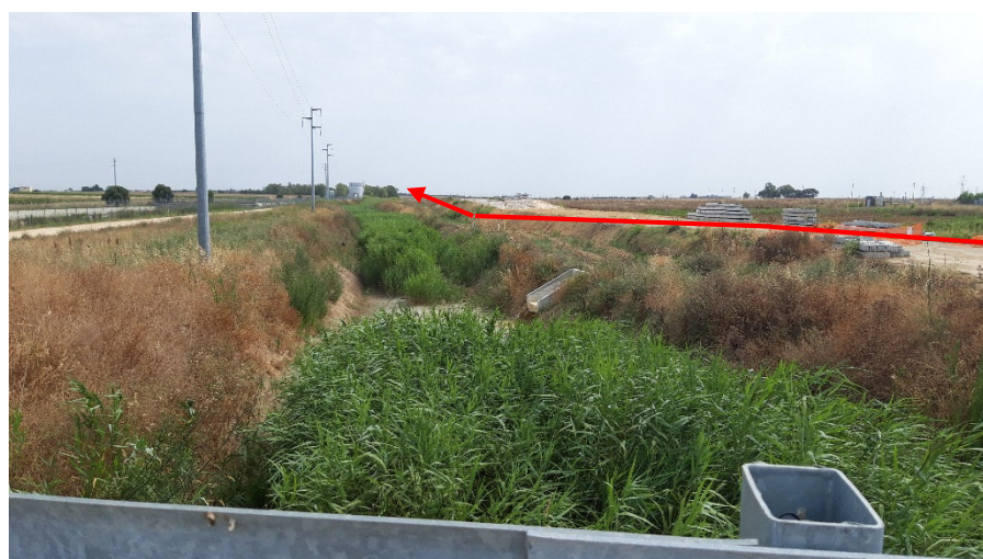
FOTO 2 – Raccordo ferroviario in costruzione
