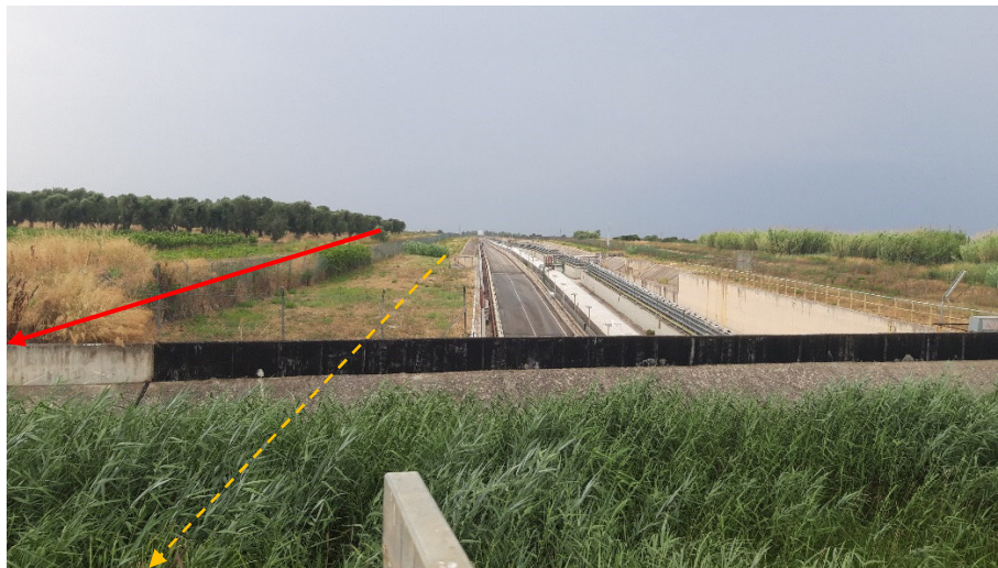
FOTO 4 – Attraversamento Canale Foggia di Rau e uliveto in TOC con parallelismo Oleodotto DN 400 (16")
