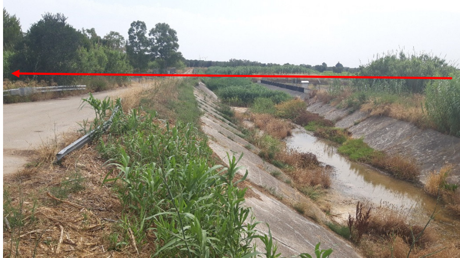
FOTO 3 – Attraversamento Canale Foggia di Rau in TOC
