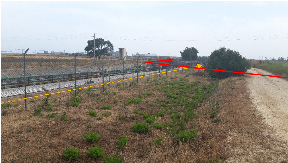
FOTO 5 – Attraversamento Asse Attrezzato Policombustibile, Oleodotto e Strada Comunale N.78 in TOC
