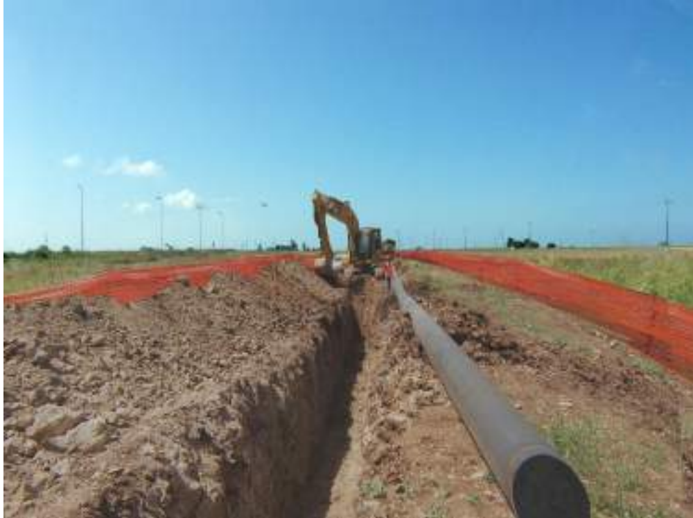
Foto 3: Cantiere in corso
