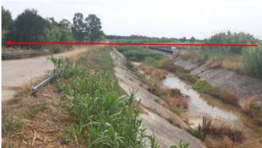
Foto 7 – Attraversamento Canale Foggia di Rau in TOC
