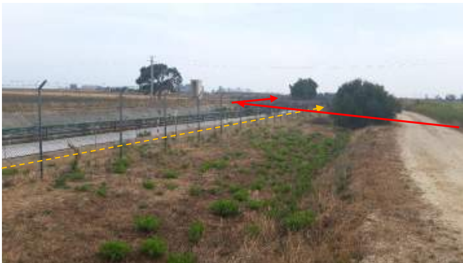
Foto 8 – Attraversamento Oleodotto, Asse Attrezzato Policombustibile e Strada Comunale N.78 in TOC
