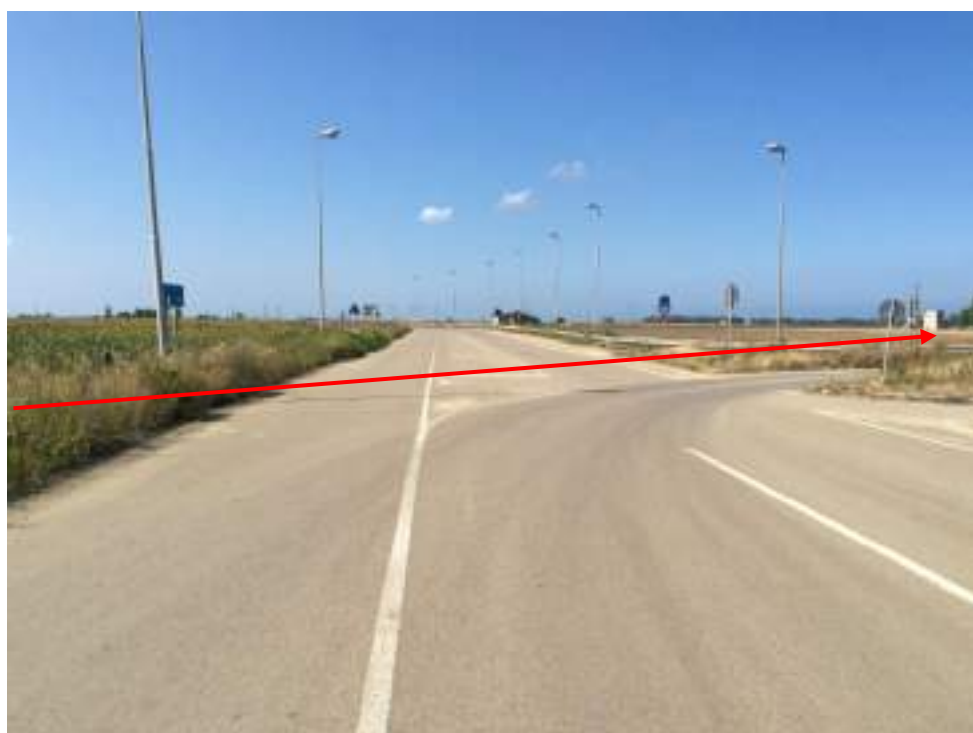
Foto 10 – Attraversamento con trivellazione spingitubo della S.P. n.88
