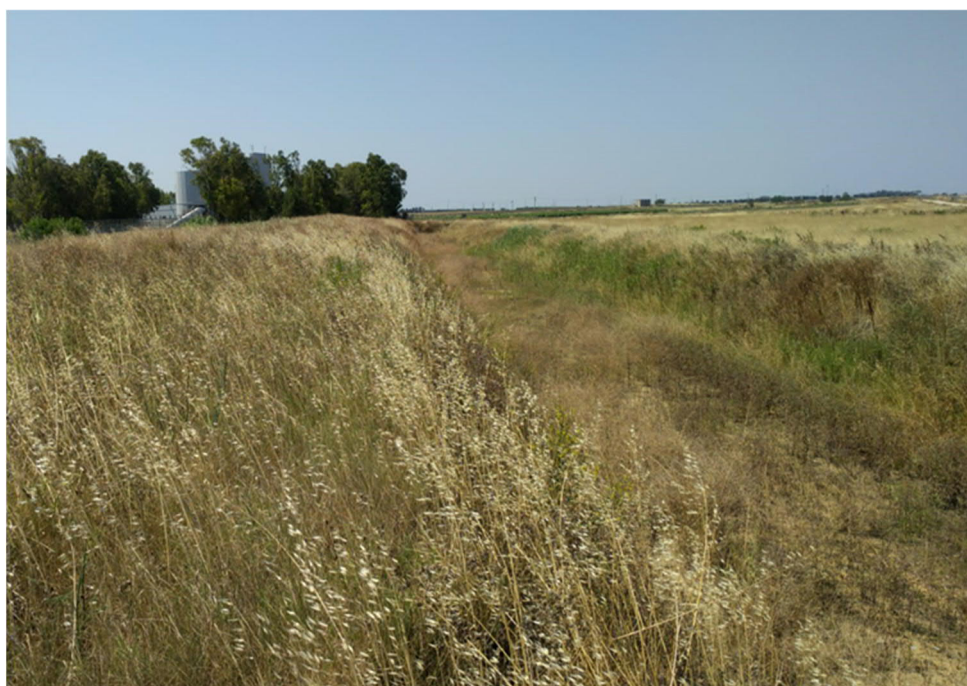
Fig.3/A: Affluente Fiume Grande, in alto lo stralcio della sezione dell'attraversamento. Sotto vista della zona a valle dell'attraversamento del metanodotto All. Centrale Enel Brindisi sud DN 500 (20") (vista verso sud)
