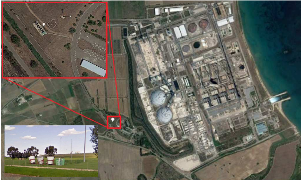
Figura 7.2.5 – Localizzazione ex postazione di monitoraggio attiva fino al 2015
