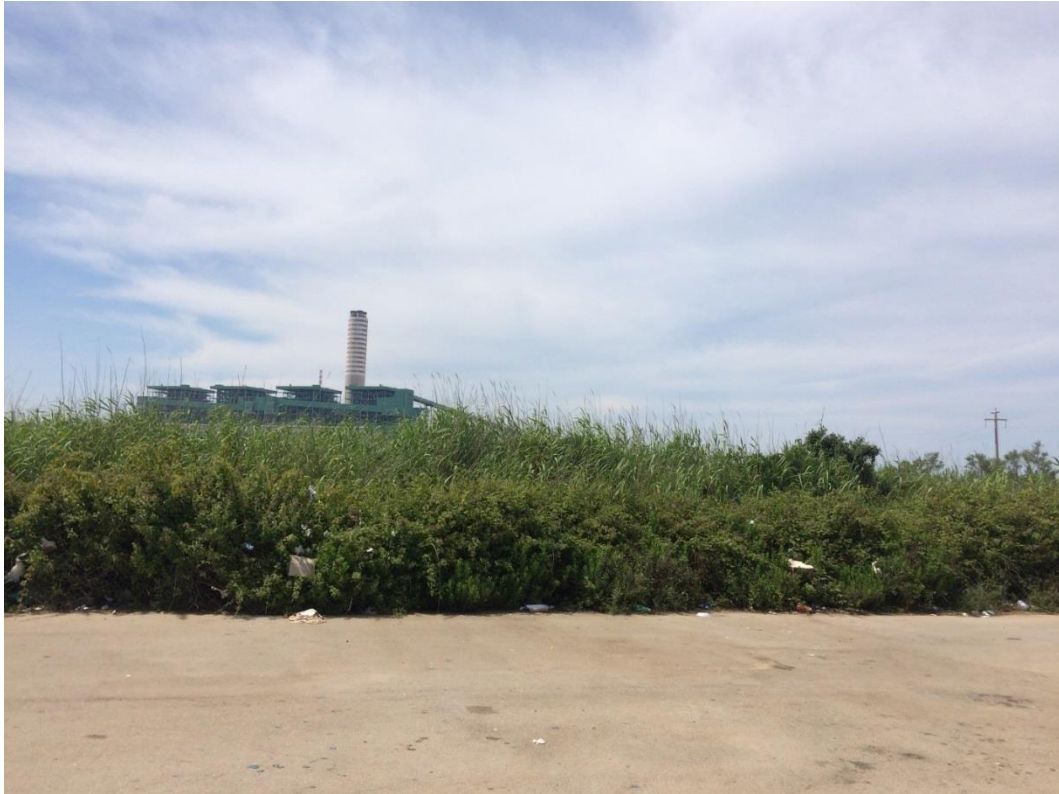
Figura 2.2.1 – Punto di vista 1 – Stato di fatto
