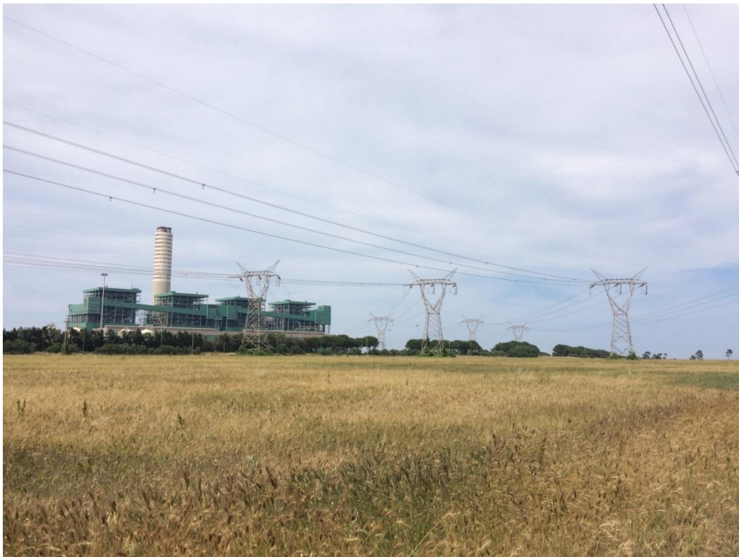
Figura 2.2.4 – Punto di vista 2 – Stato di fatto
