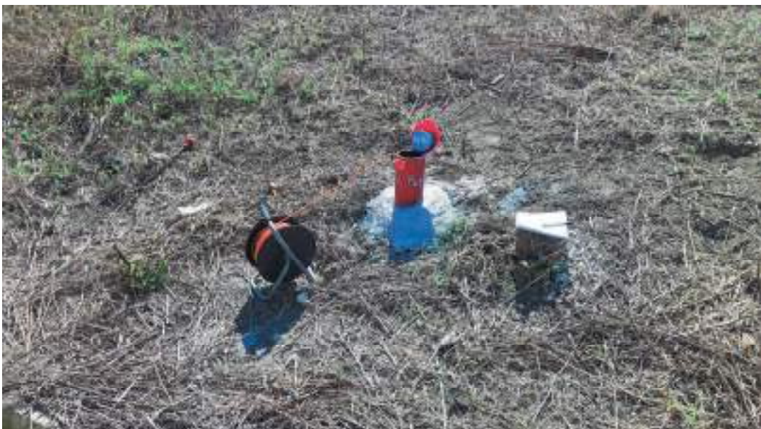
Misurazione del livello statico falda da S4-Pz3
