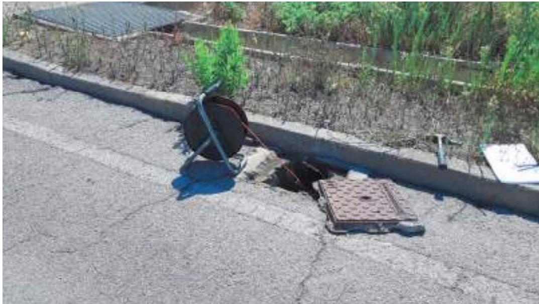
Misurazione del livello statico falda da P115
