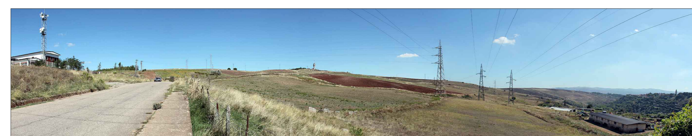
PAN 03 _ Vista dalla SP 111 in prossimità della Cabina Primaria di Melfi
