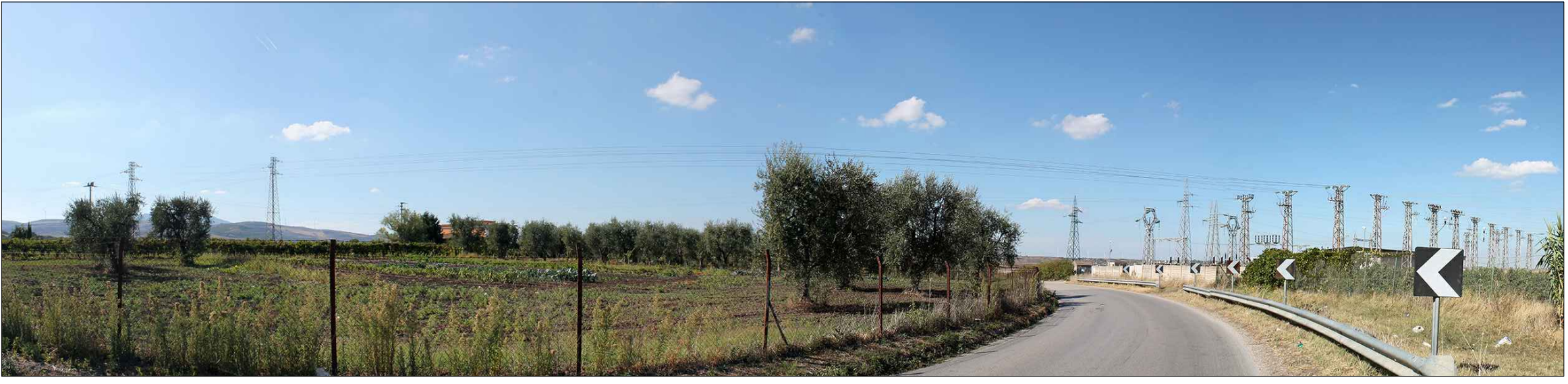
PAN 05 _ Vista dalla SP 109 dei traiecci in uscita dalla Cabina Primaria di Venosa
