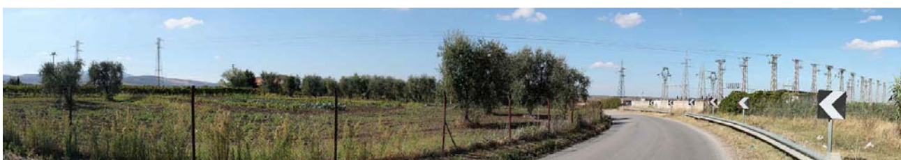
Figura 5 – Vista dell’elettrodotto in prossimità della cabina primaria di Venosa
