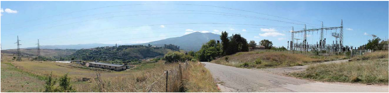
Figura 6 – Vista dell’elettrodotto in prossimità della cabina primaria di Melfi
