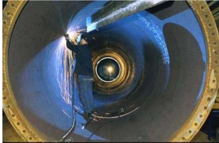
Figura 10: interno di una torre
