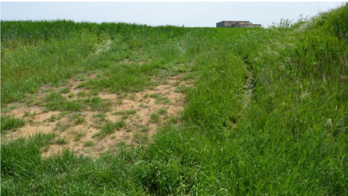
Fig. 4 cavidotto di accesso a GIP 5
