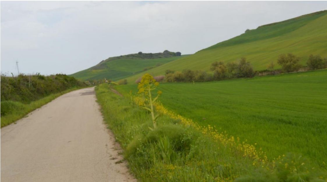
Fig. 3 cavidotto lungo la sp 26
