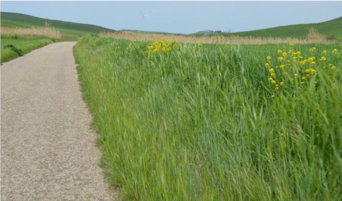
Fig. 7 cavidotto lungo la sp 26
