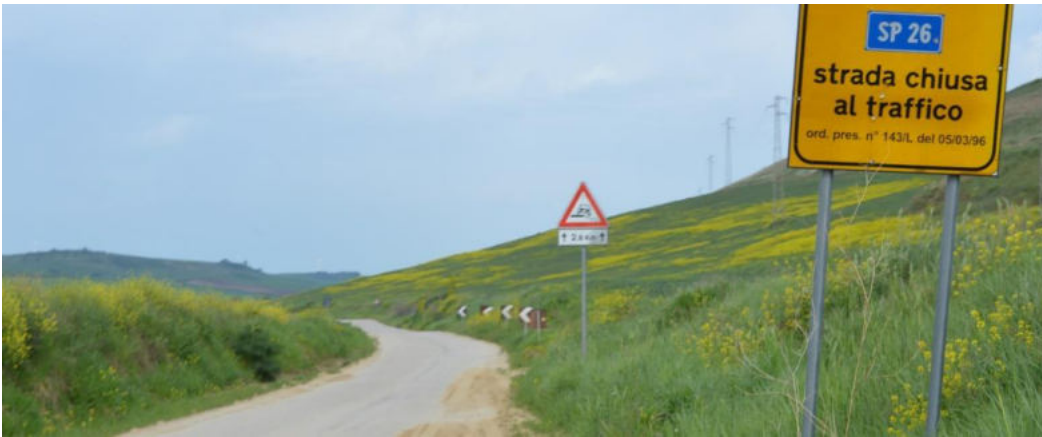
Fig. 1 cavidotto lungo la sp 26
