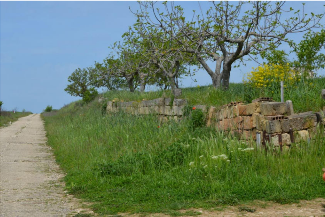
Fig. 2 cavidotto di accesso a GIP 1
