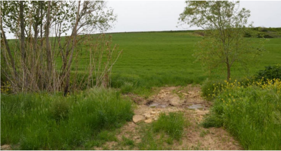
Fig. 1 cavidotto a GIP 9
