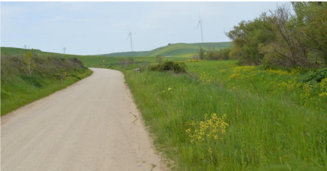
Fig. 6 cavidotto lungo la sp 26
