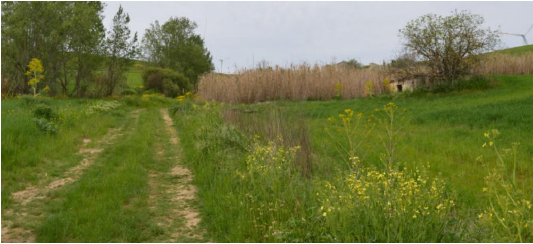
Fig 1 cavidotto di accesso a GIP 8
