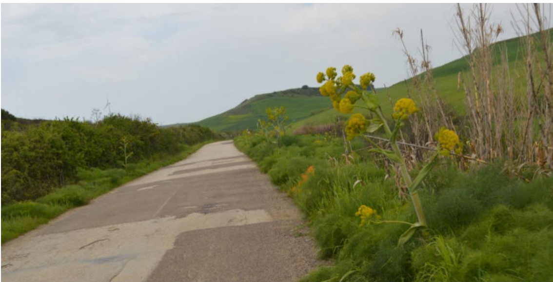
Fig. 2 cavidotto lungo la sp 26
