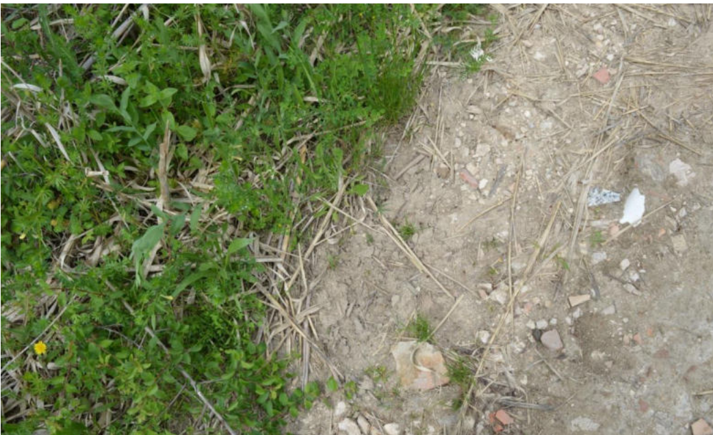
Fig. 4 particolare su strada in terra battuta
