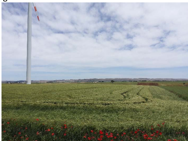
Figura 30 - Stato dei luoghi in prossimità dell'aerogeneratore n. 5
