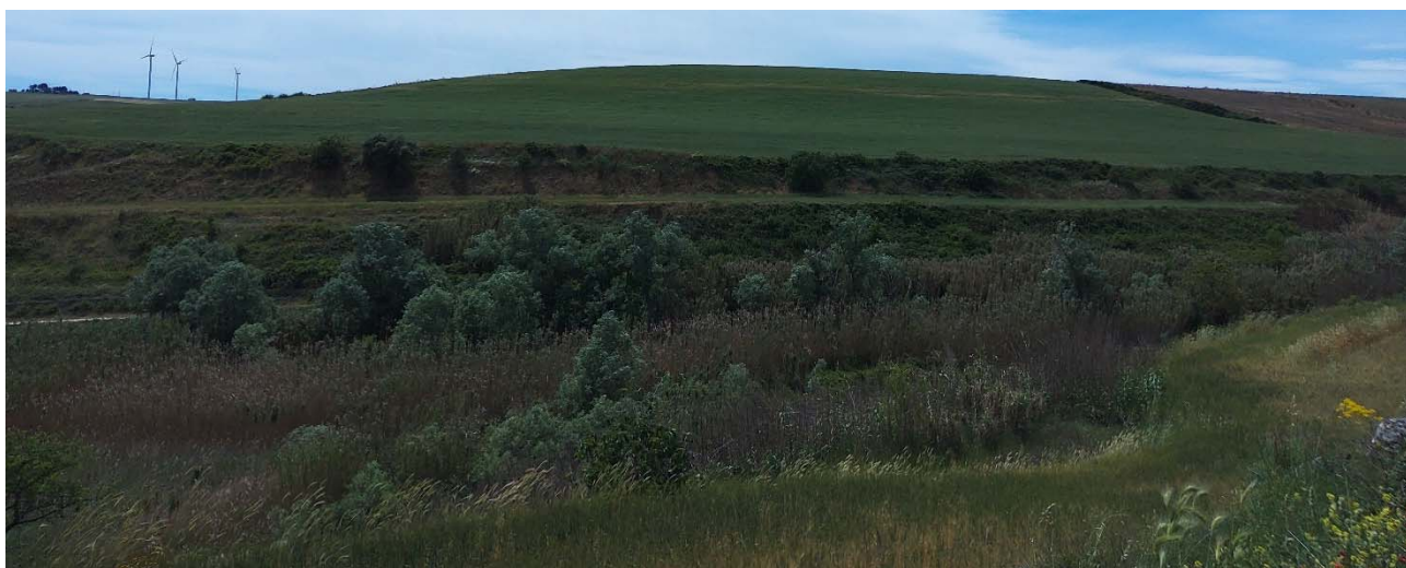
Figura 31 - Stato dei luoghi in prossimità dell'aerogeneratore n. 12
