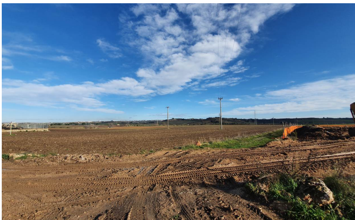
Foto P2: Vista dell'area di installazione dell'aerogeneratore ATM 01, in prossimità del tratto di inizio della viabilità esistente da adeguare che conduce ad ATM01
