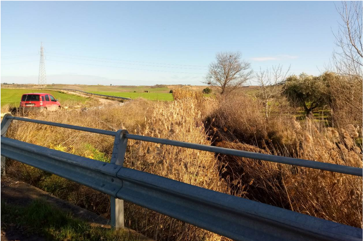
Foto P12.2: Vista del reticolo idrografico secondario, attraversato in TOC
