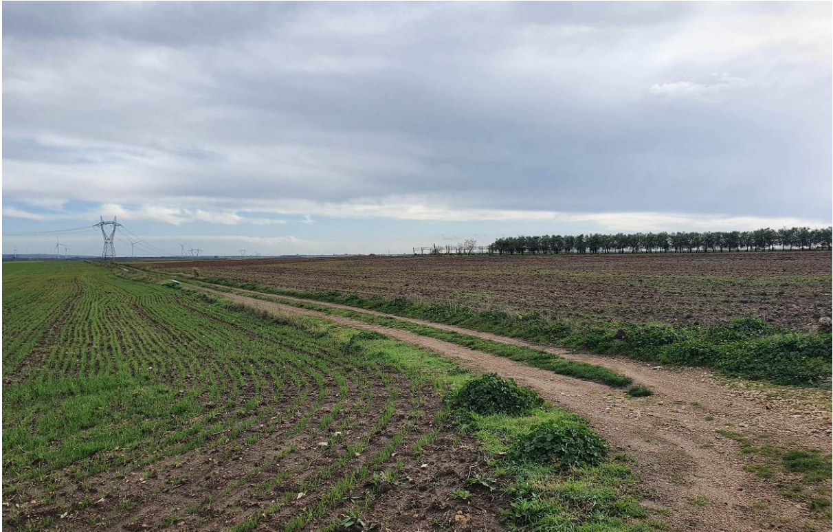
Foto P8: Vista dell'area di installazione dell'aerogeneratore ATM 6 e della viabilità secondaria esistente interessata dal passaggio del cavidotto interno
