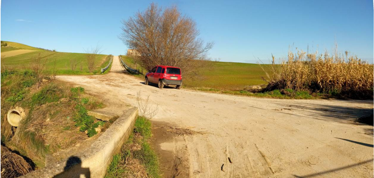
Foto P16.1: Vista della viabilità interna esistente da adeguare verso l'aerogeneratore ATM 12 in prossimità dell'attraversamento di due reticoli idrografici secondari, interessati dal passaggio del cavidotto in TOC
