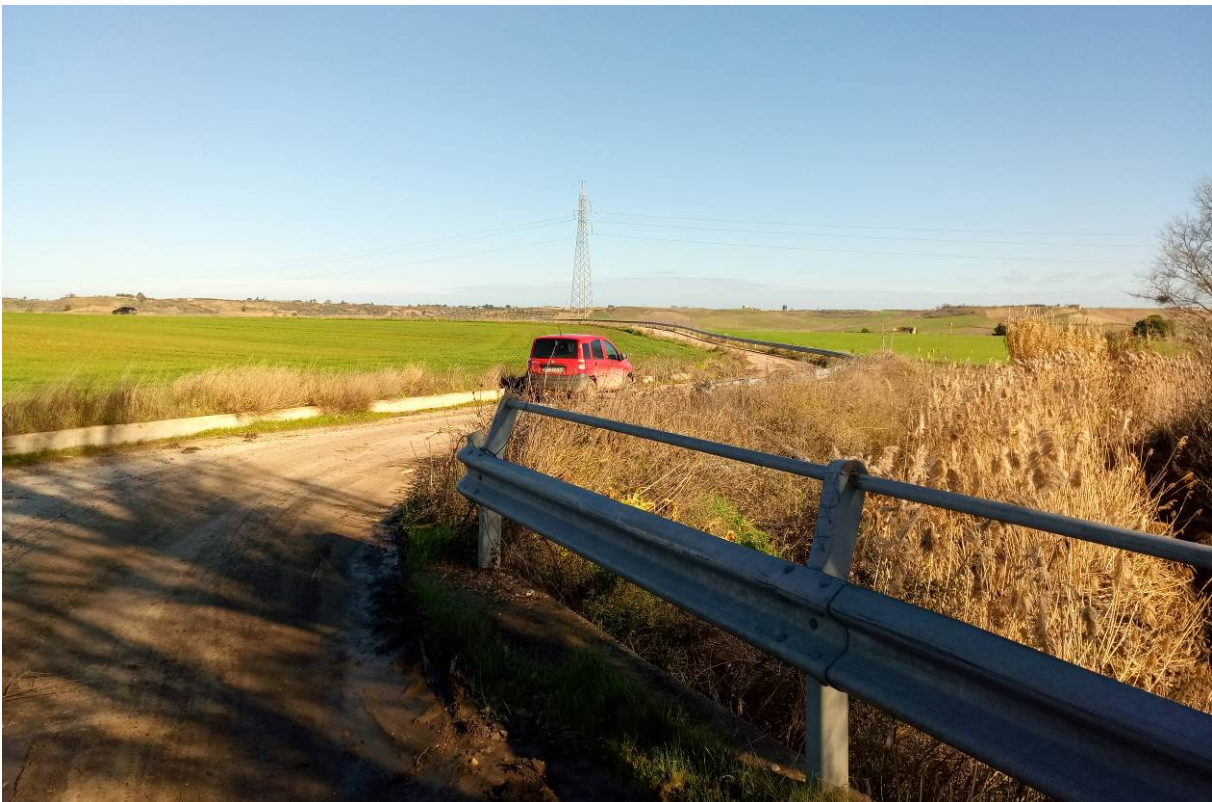
Foto P12.1: Vista della viabilità secondaria esistente interessata dal passaggio del cavidotto interno, in prossimità dell'attraversamento di un reticolo idrografico secondario,
