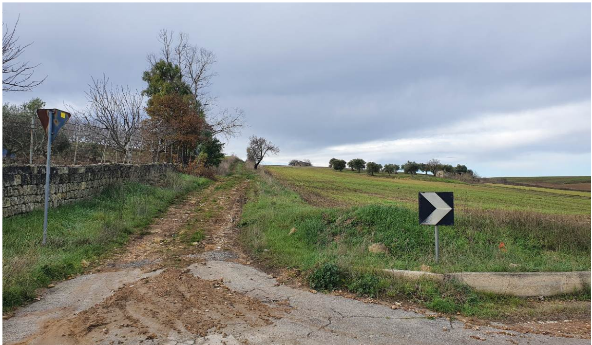
Foto P15: Vista in direzione dell'area di installazione dell'aerogeneratore ATM 5 e della viabilità secondaria esistente da adeguare, interessata dal passaggio del cavidotto
