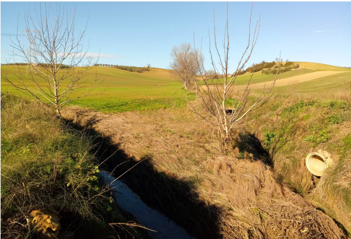
Foto P16.2: Vista di due reticoli idrografici secondari, interessati dal passaggio del cavidotto in TOC
