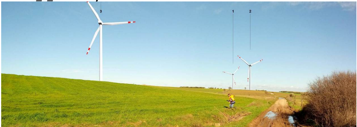
Vista V1_3_NO post operam - Vista verso Nord-Ovest
