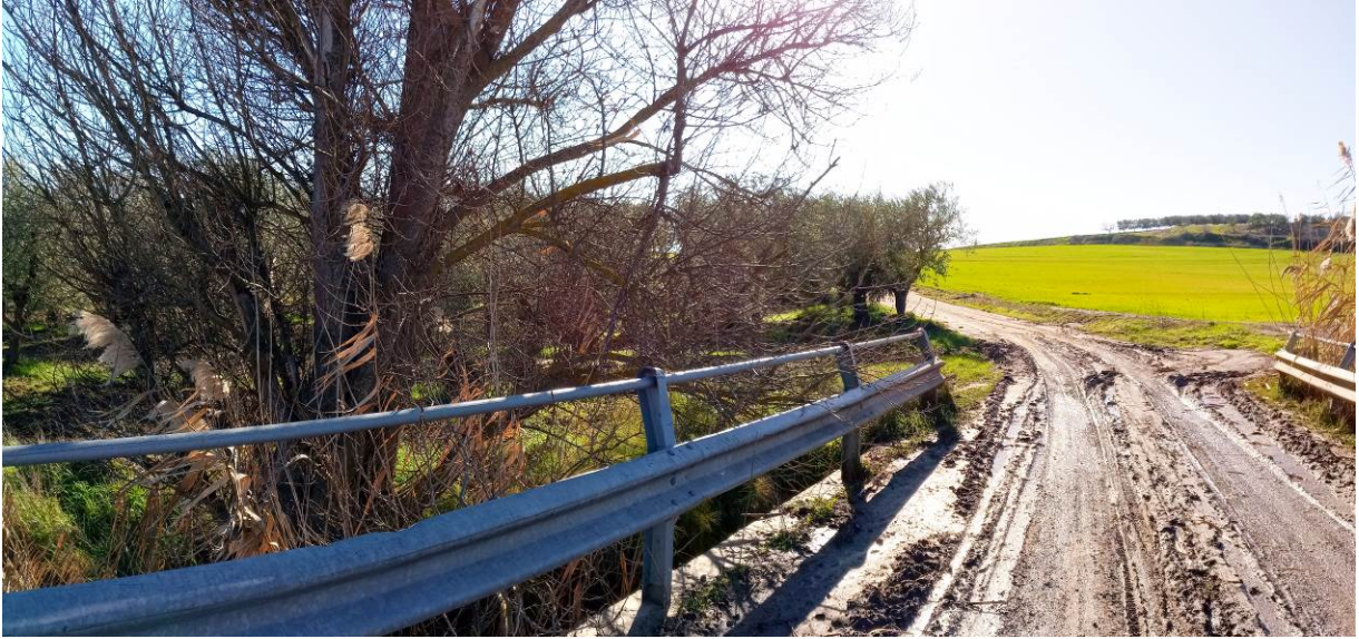
Vista V1_2_SE ante operam - Vista verso Sud-Est
