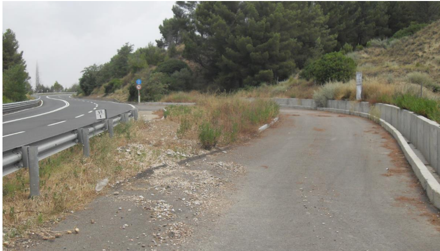
Vista dell'accesso di servizio esistente SS7 racc
