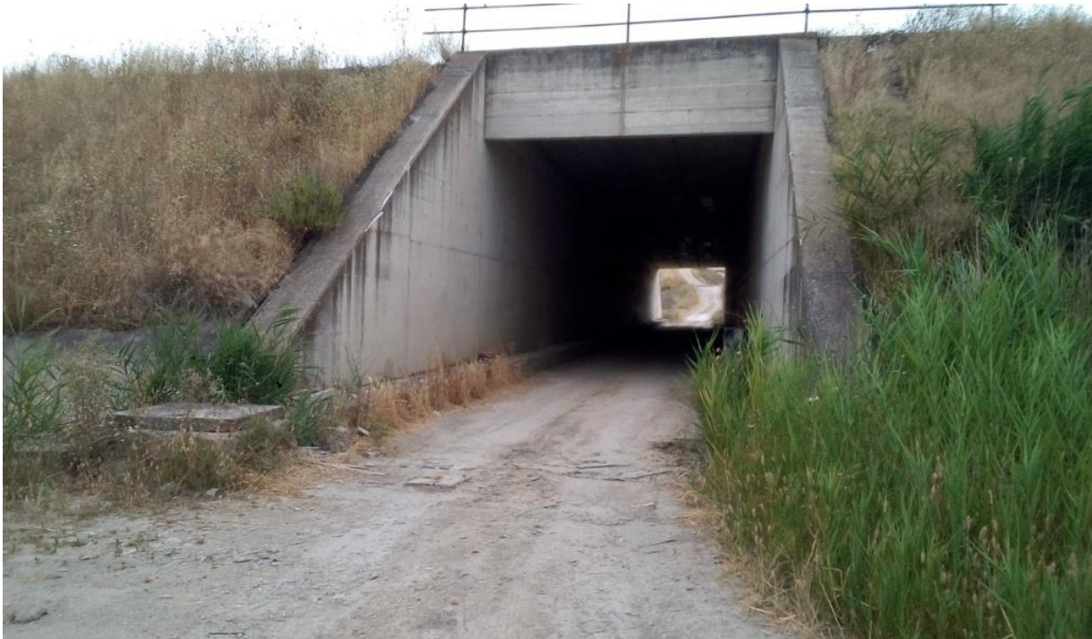
Vista del sottovia esistente sottopassante il piazzale di stazione di Matera La Martella
