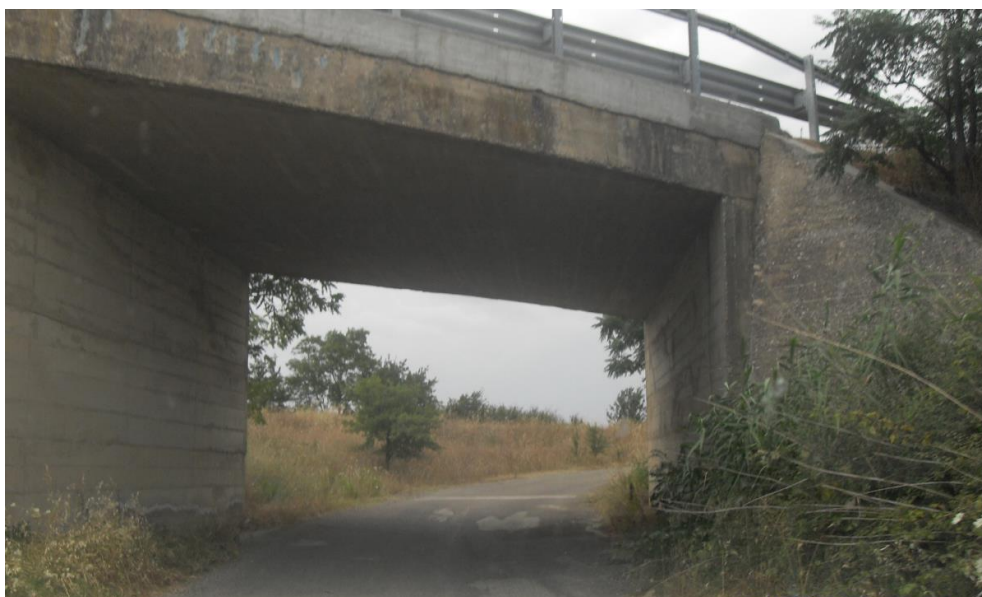
Sottovia sulla SP211
