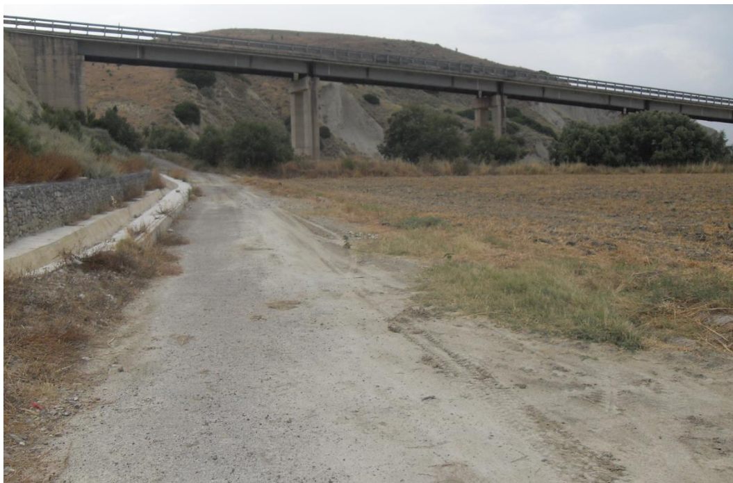
Strada di servizio in uso a Italgas (fondovalle Basento)
