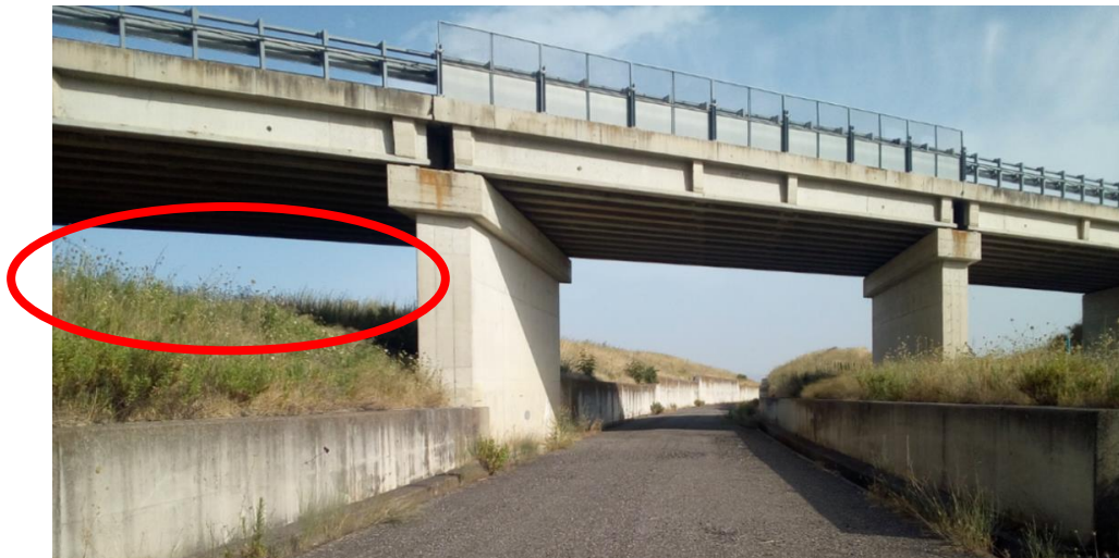
Cavalcaferrovia esistente in prossimità della stazione di Matera (lato Ferrandina) sottopassato dalle piste di cantiere
