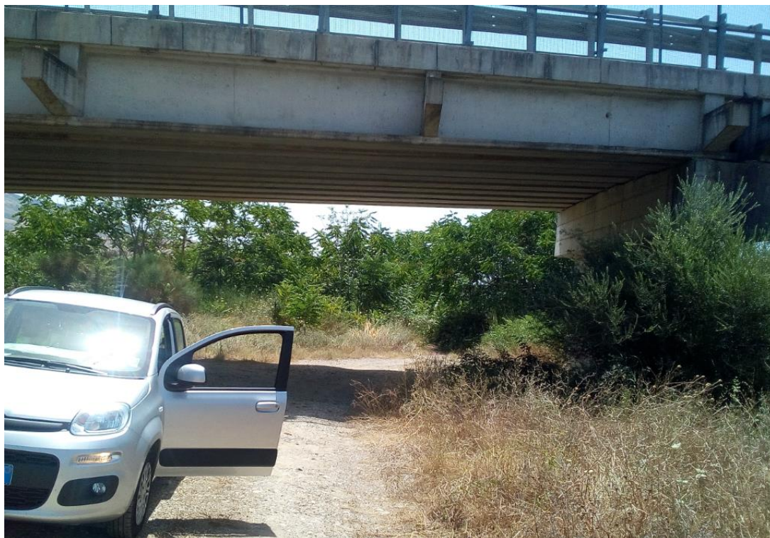
Cavalca ferrovia esistente per l'accesso al cantiere AR.01
