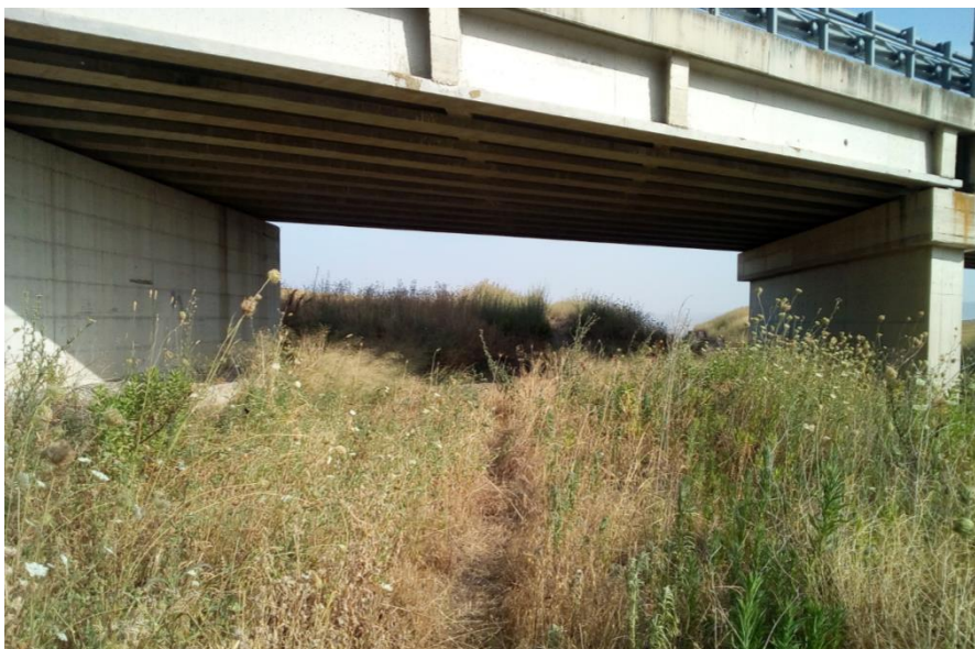
Campata lato Matera del cavalcaferrovia
