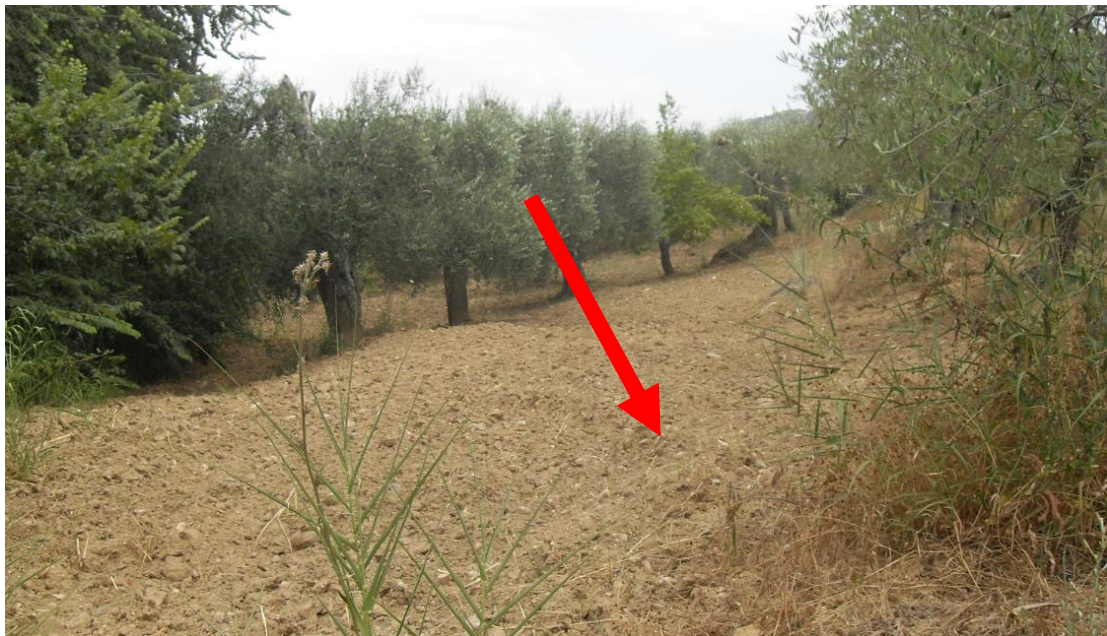
Pista di cantiere di accesso all'area AT.06
