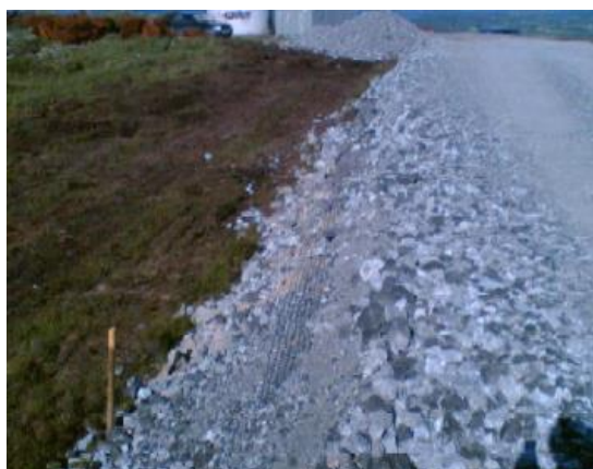
Figura 11: Superficie stradale in misto stabilizzato e drenaggio
