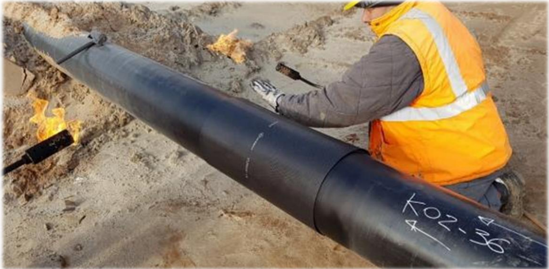
Figura 2-11 – Applicazione manuale di una fascia termorestringente su giunto saldatura
