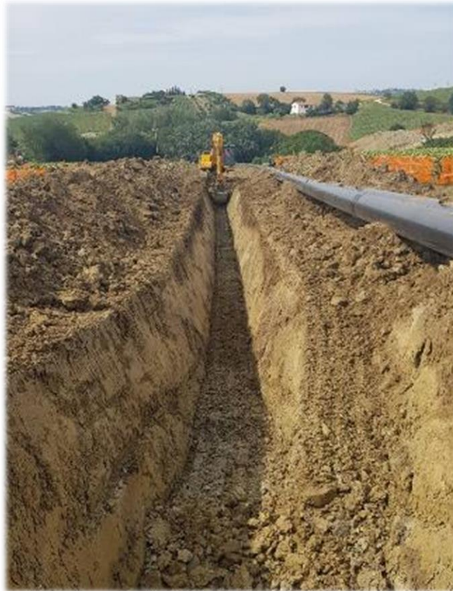
Figura 2-10 – Scavo della trincea
