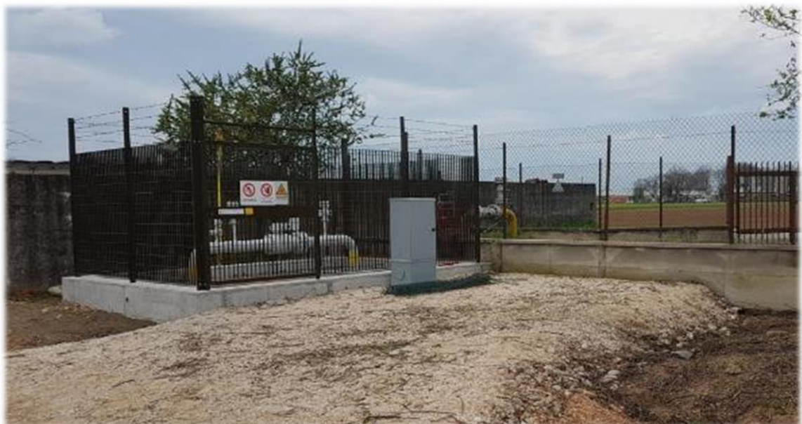
Figura 2-22 – Esempio di punto di linea al termine dei lavori
