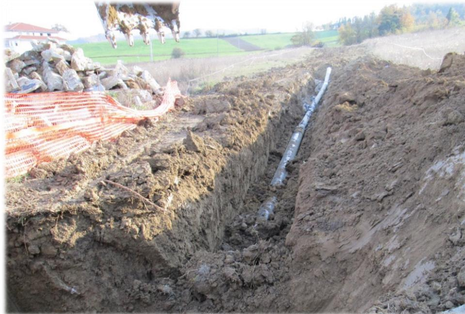
Figura 2-30 – Esempio di scavo e sezionamento della condotta da rimuovere
