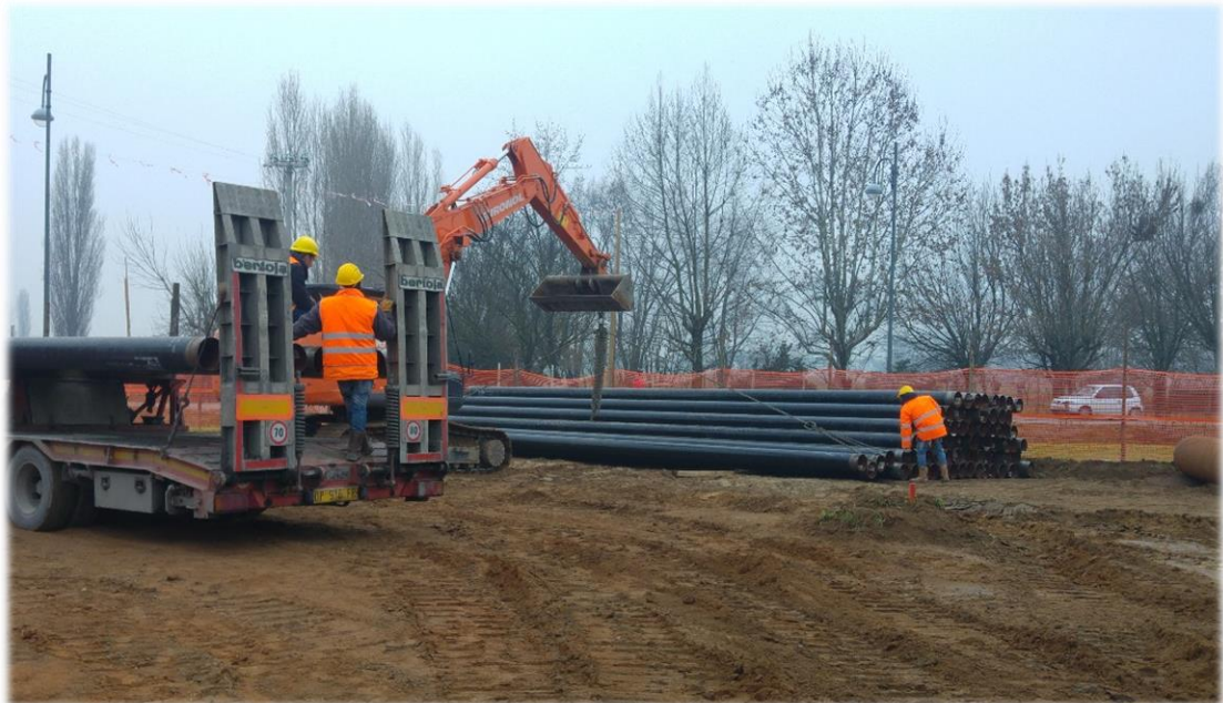
Figura 2-4 – Piazzola di accatastamento tubazioni
