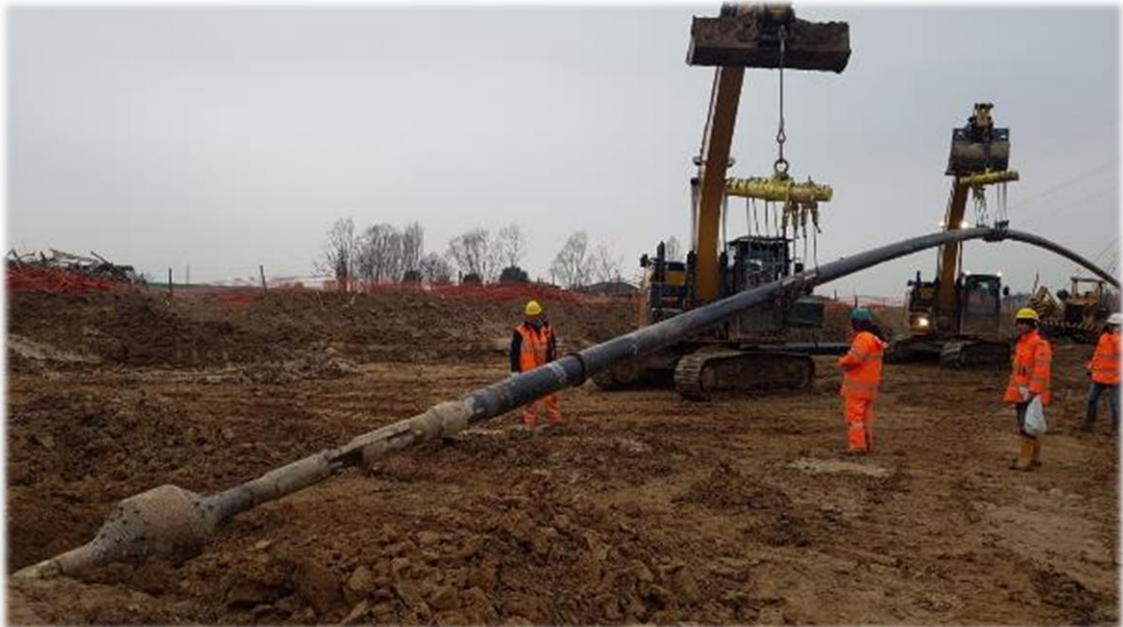
Figura 2-21 – Esempio di operazione di varo della TOC
