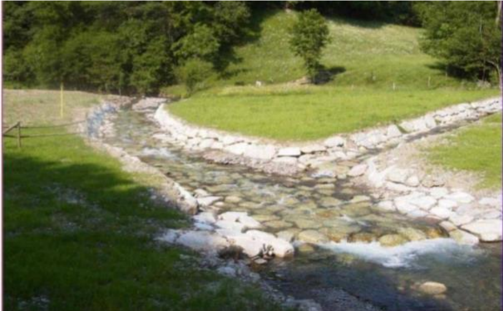
Figura 2-35 – Esempio di rivestimento fondo alveo con materassini metallici
