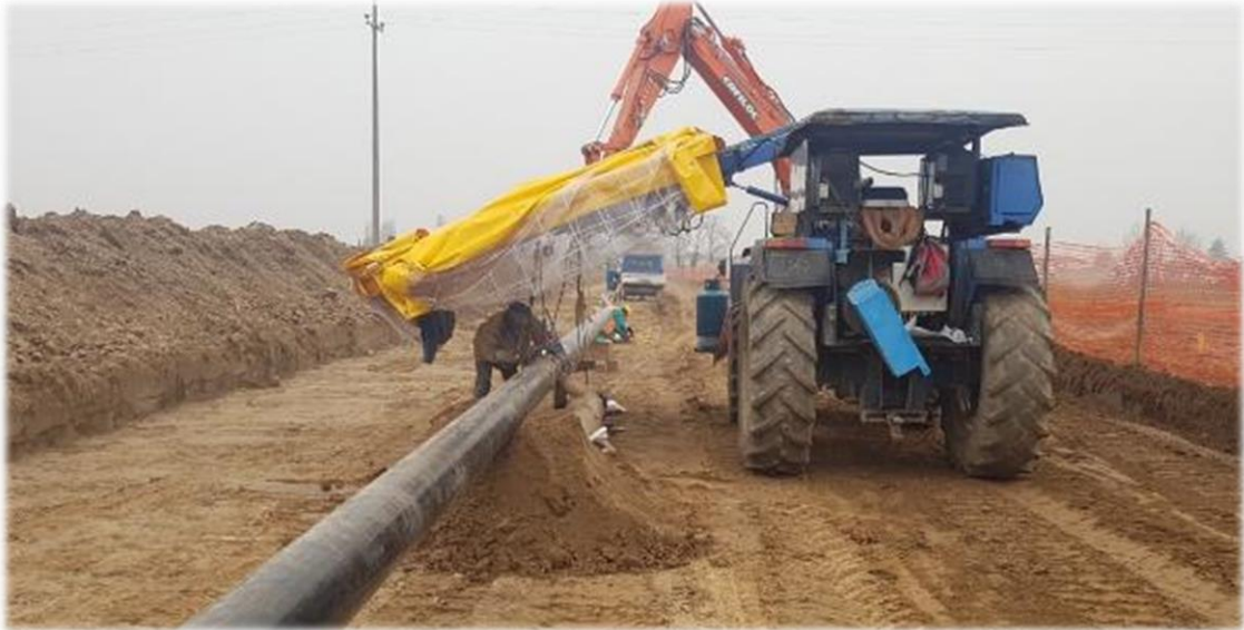
Figura 2-9 – Fase di saldatura manuale
