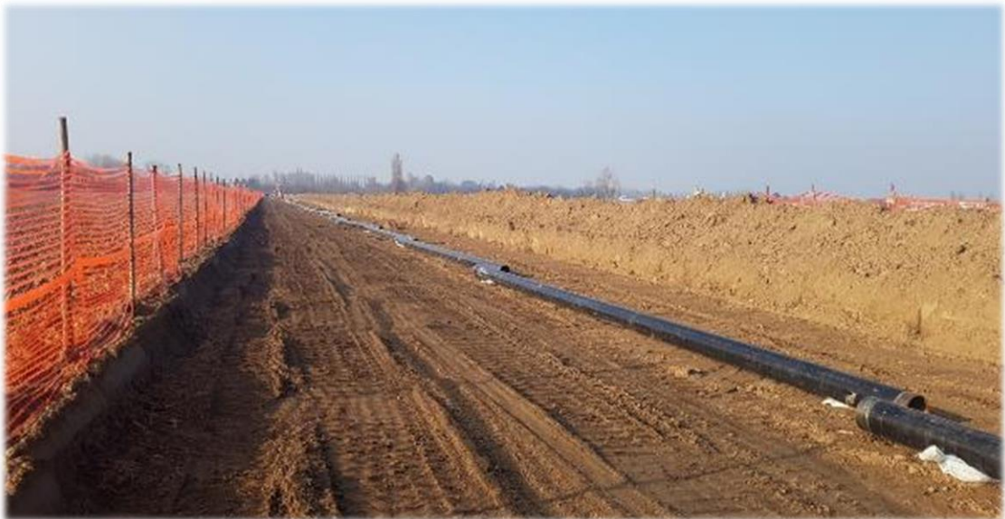
Figura 2-8 – Sfilamento delle tubazioni di linea
