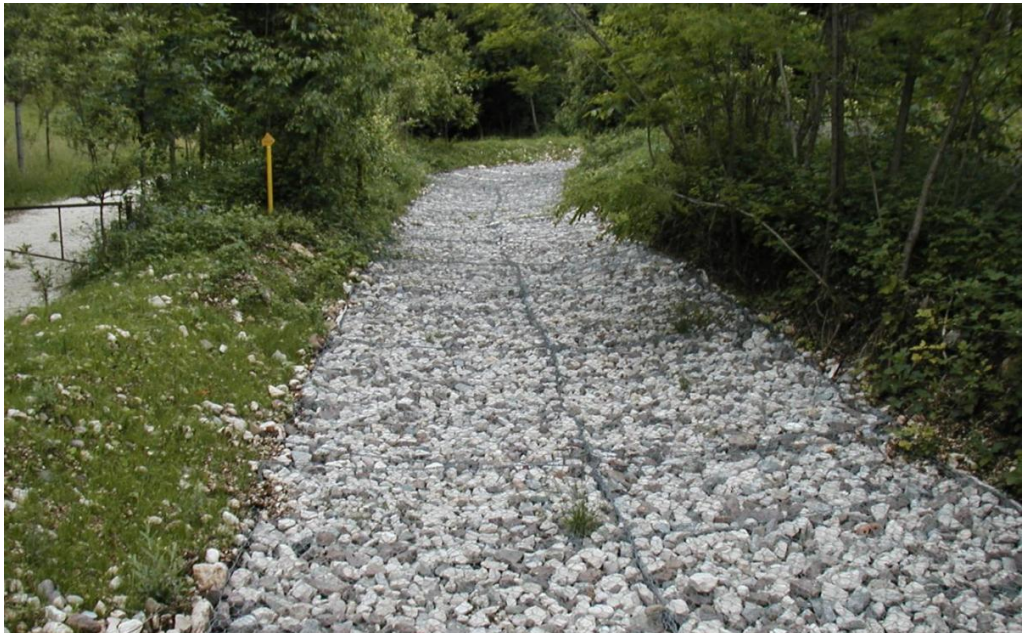
Figura 2-35 – Esempio di rivestimento fondo alveo con materassini metallici
