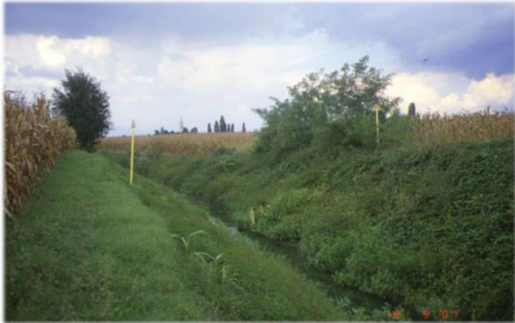
Figura 2-25 – Esempio di opera ultimata in corrispondenza di attraversamento di corso d'acqua in ambito agricolo
