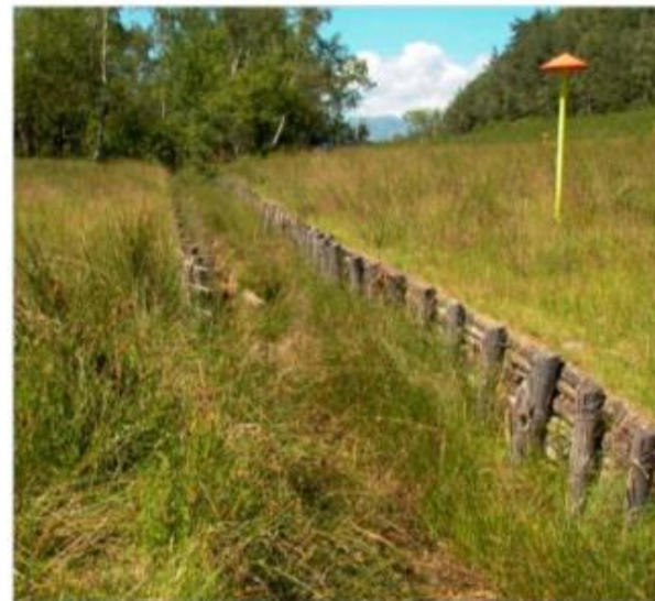
Figura 2-33 – Schema ed esempio di palizzata
