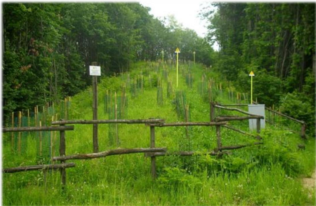
Figura 2-24 – Esempio di opera ultimata in ambito boscato
