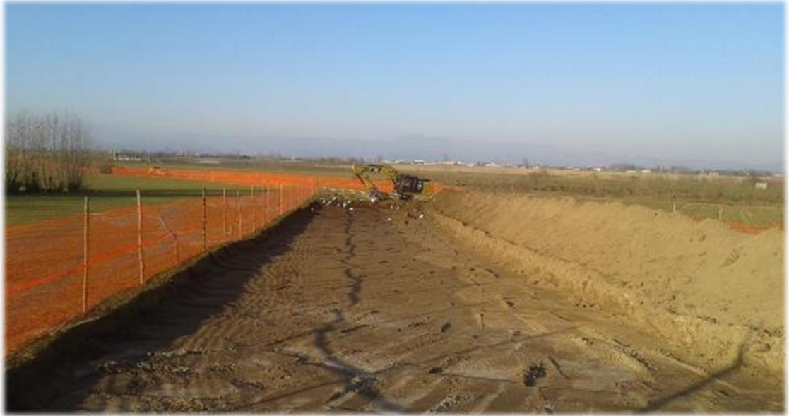
Figura 2-5 – Foto di apertura della pista di lavoro
