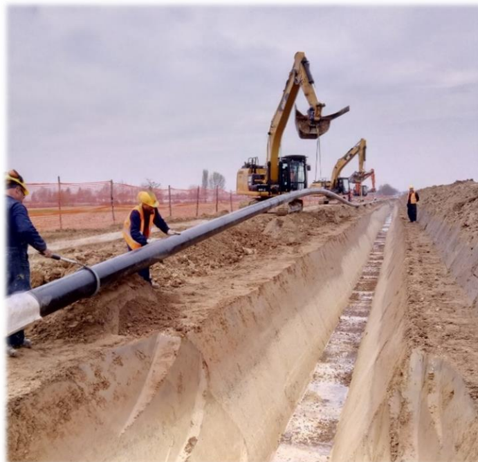
Figura 2-12 – Posa della condotta
