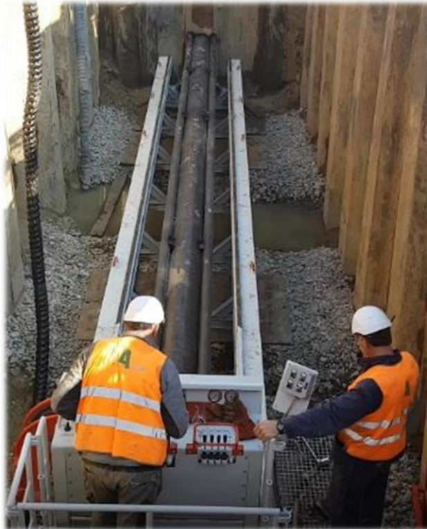
Figura 2-17 – Esecuzione di trivellazione spingitubo
