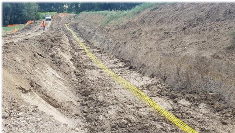
Figura 2-13 – Rinterro della condotta
