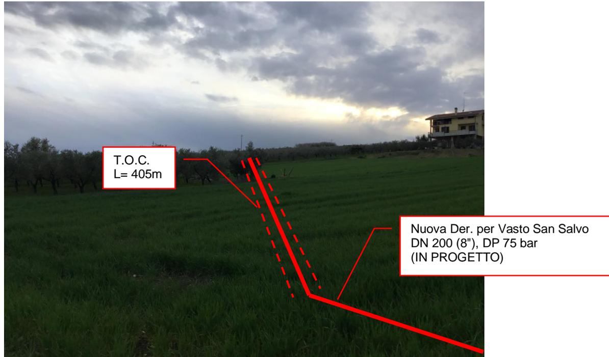
Foto n.17 – Km 6+000 - Metanodotto in progetto con vista T.O.C.
