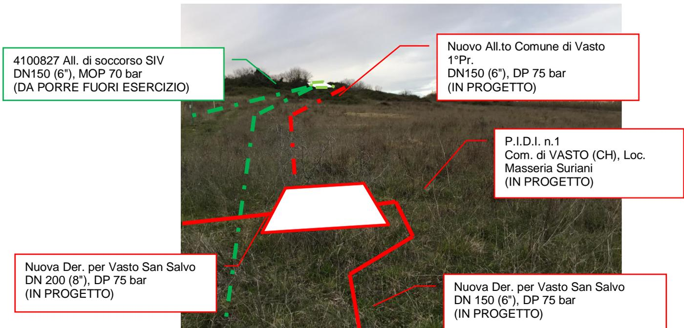
Foto n.18 – Km 6+200 - Met. in progetto con vista impianto PIDI n.1 in progetto e met. da porre fuori esercizio
