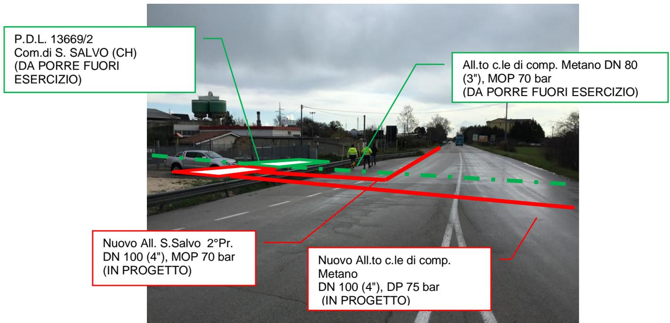
Foto n.28 – Km 8+700 - Vista Area impianti e metanodotti in progetto e da porre fuori esercizio
