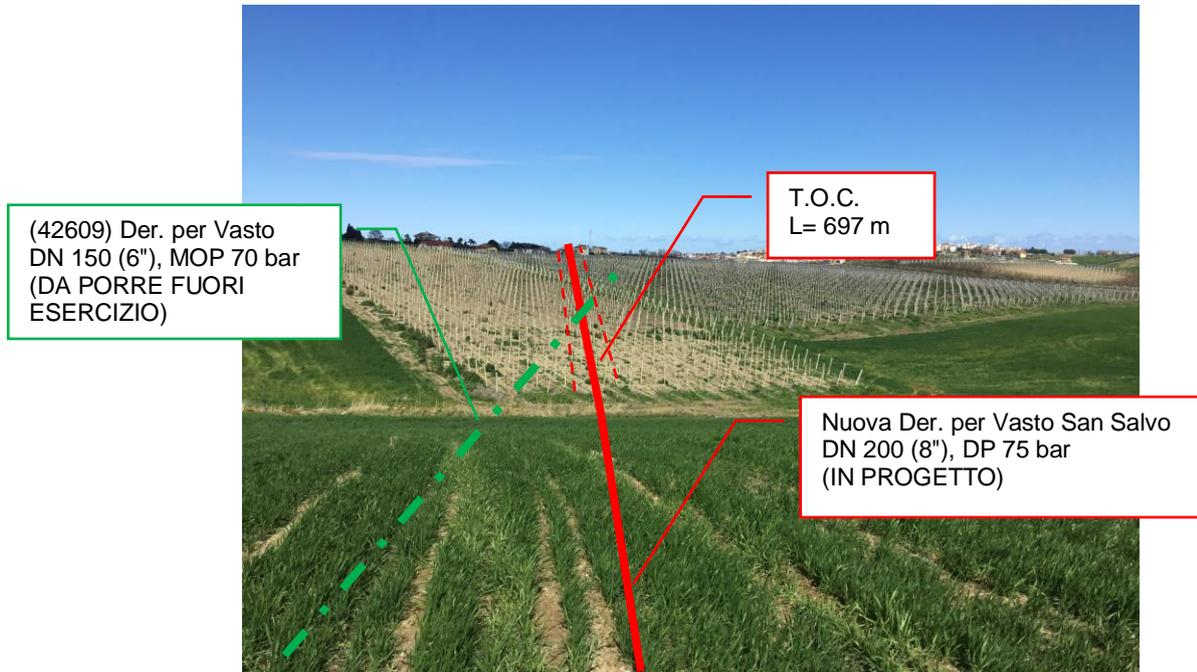
Foto n.9 – Km 1+506 - Metanodotto in progetto con vista T.O.C. e metanodotto da porre fuori esercizio
