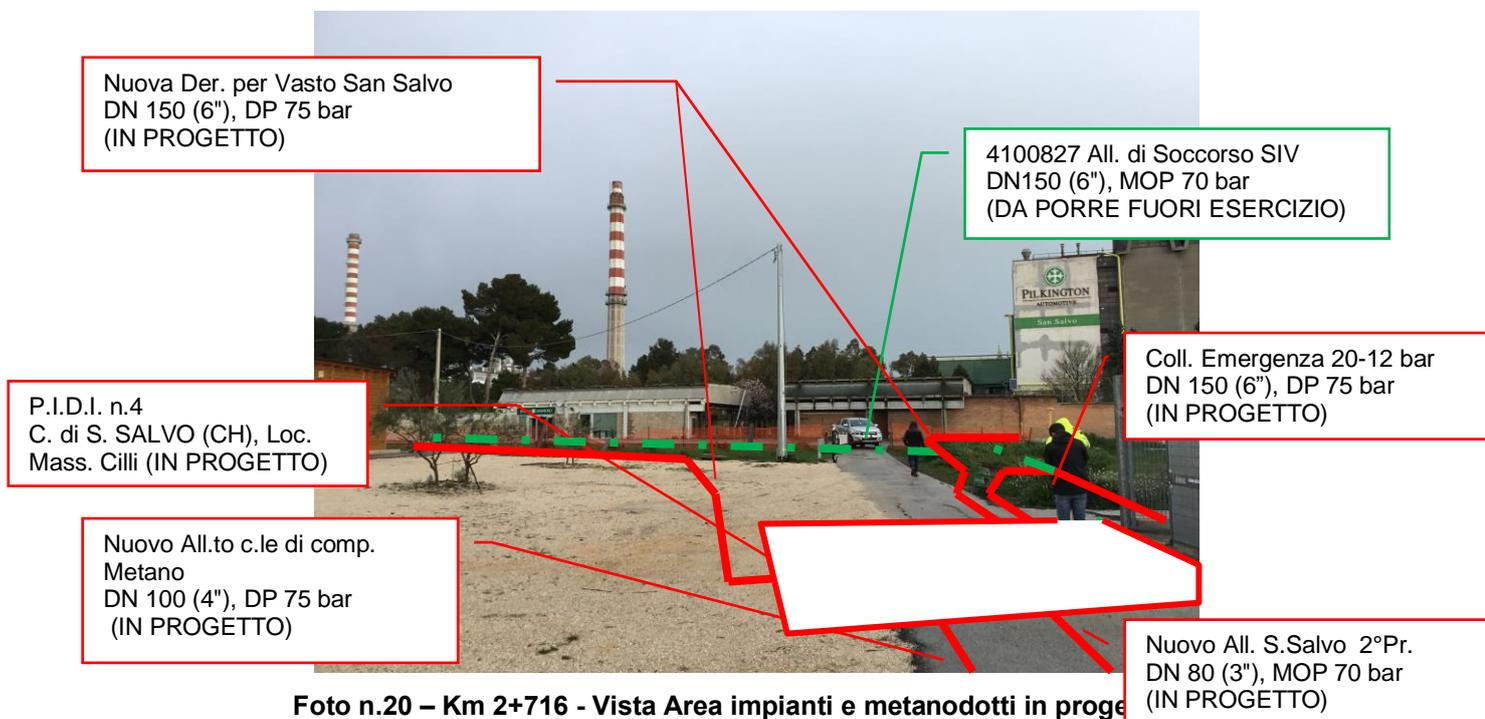
Foto n.20 – Km 2+716 - Vista Area impianti e metanodotti in progetto
