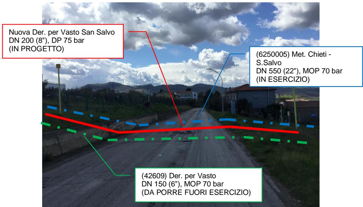
**Foto n.4 – Km 0+163 - Attraversamento metanodotti su S.P. 187 (S.P. Trignina)**
