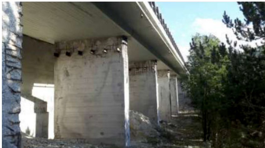
Fig. 2 Dettaglio del Viadotto Fuggetto Fonte: Rapporto Ambientale
