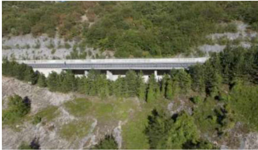
Fig. 1 Viadotto Fuggetto Fonte: Rapporto Ambientale
