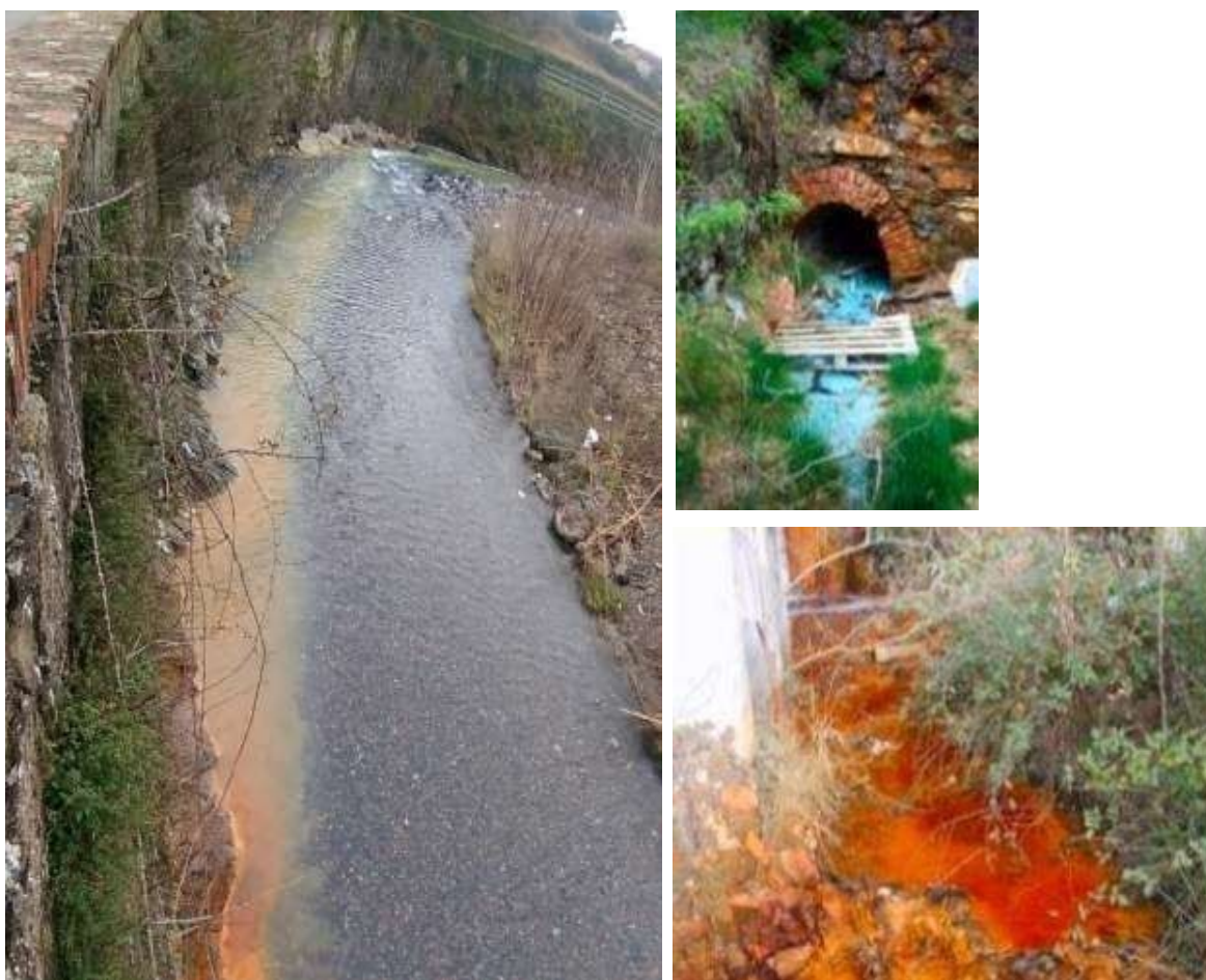
Figura 24 - Drenaggio acido ad oggi presente nel Torrente Gromolo e in prossimità delle vecchie gallerie minerarie di Libiola
