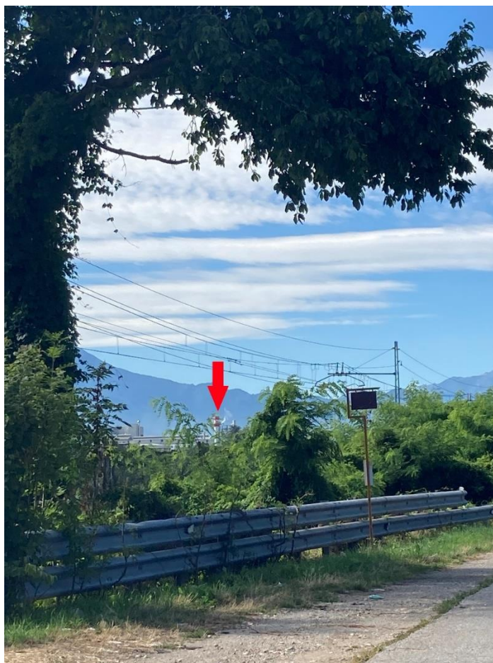
Foto 4: Indicazione del camino dello attuale Centrale Termica dello stabilimento Michelin dal punto B punto A (vedere Foto1)
