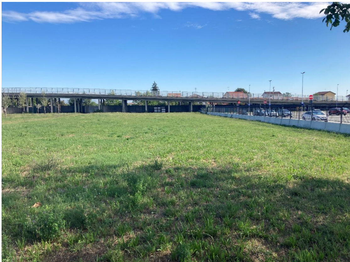
Foto 3.2: Area nuova Centrale interno stabilimento Michelin dal punto A (vedere Foto1)
