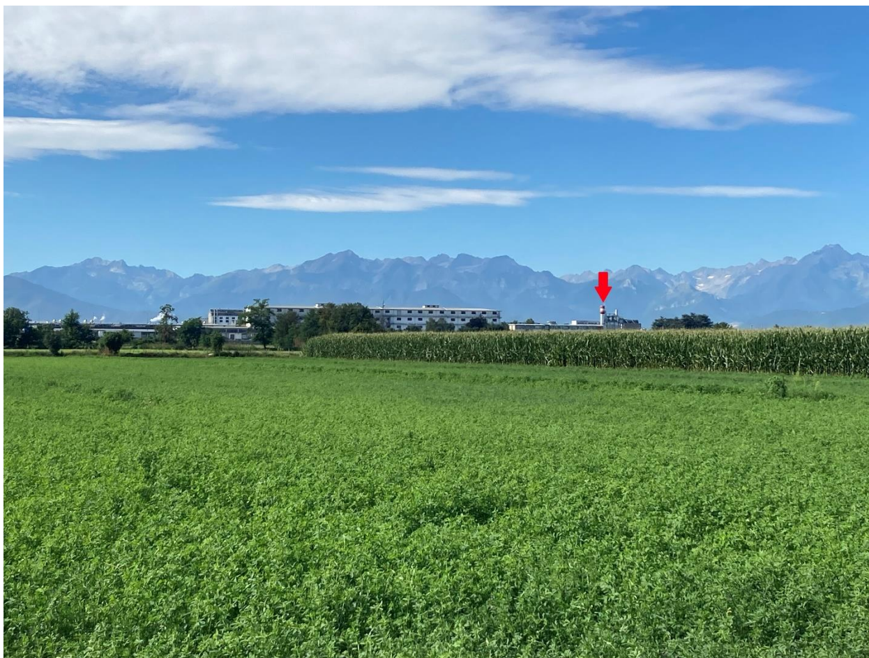
Foto 5: Indicazione del camino della attuale Centrale Termica dello stabilimento Michelin dal punto C (vedere Foto 1)
