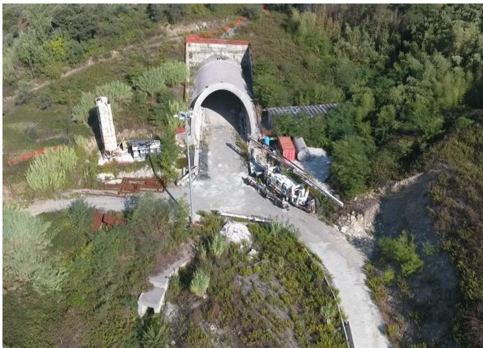
Figura 4.1 Stato Lavorazioni – Imbocco Sud GN Felettino I e tombino scatolare AI13
