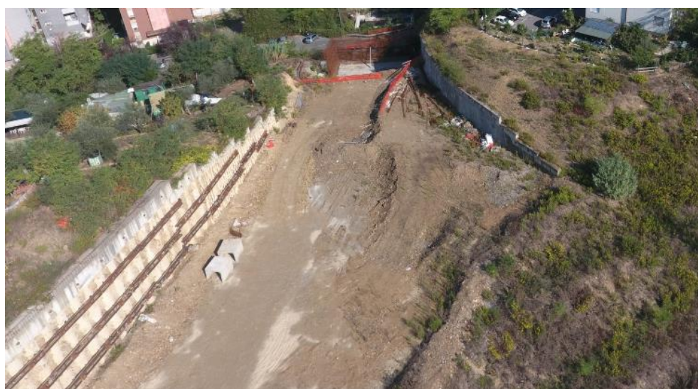
Figura 4.3 Stato Lavorazioni - Paratie MU35 eMU37
