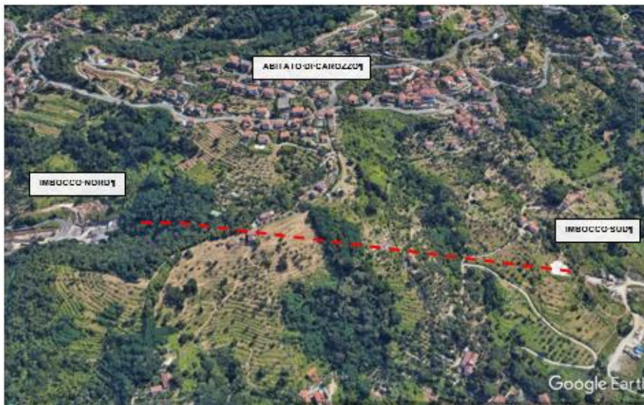
Figura 9.1 – Vista dell'area della galleria Felettino I adiacente all'abitato di Carozzo
