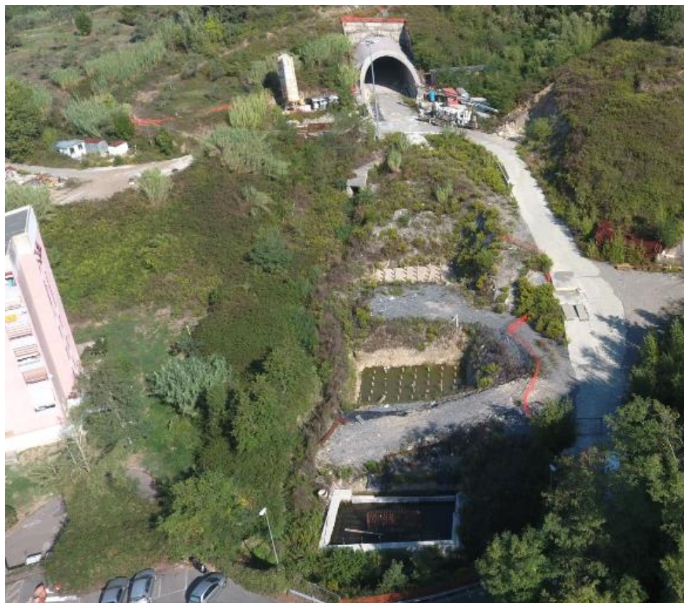
Figura 4.2 Stato Lavorazioni – Imbocco Sud GN Felettino I, Viadotto S.Venerio I,
