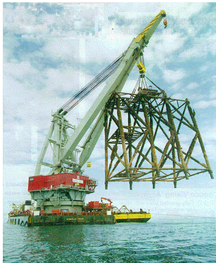
Figura 1.23- Sollevamento Completo di un Jacket
