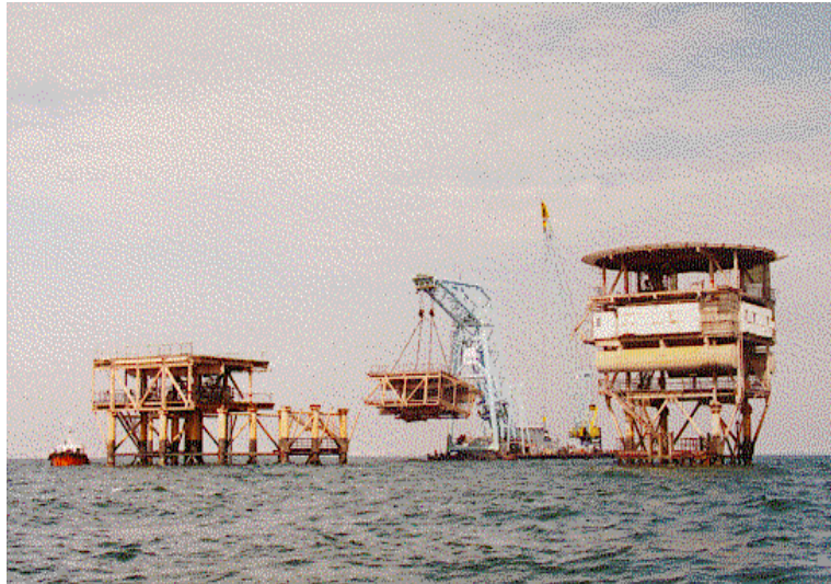
Figura 1.22 - Sollevamento di un Deck
