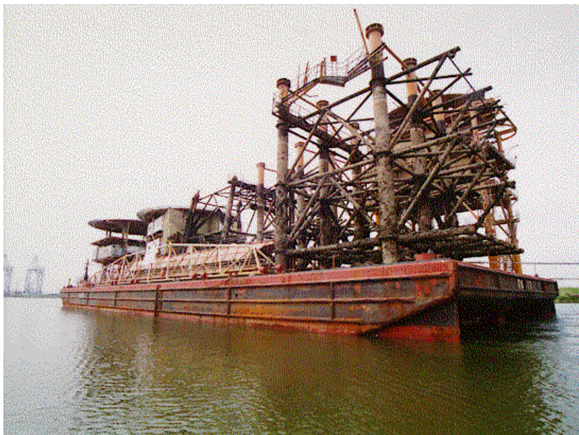
Figura 1.26 - Trasporto delle Strutture Rimosse
