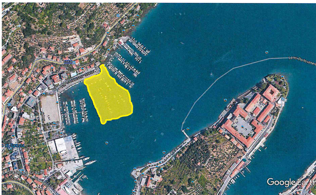
Figura 6 - Il fondale del sito di posizionamento dei pontili galleggianti. In giallo: sedimento fangoso)
